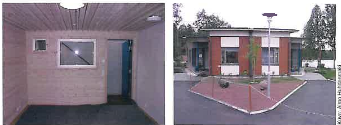
Kuva 3. Paritalo ja kellarikerroshuone Kajaanin asuntomessuilla.
