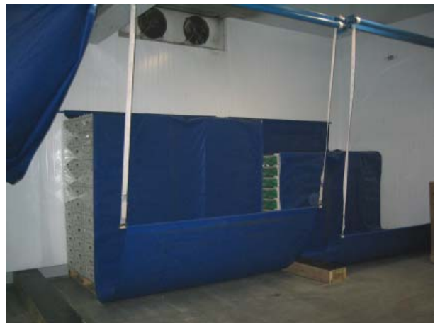
Kuvat Vihannes-Laitilan pakotetun ilmankierron jäähdytystilasta.
