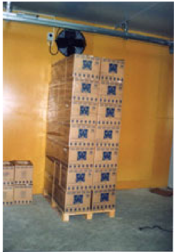
Kuva Wääksyn kartanon pakotetun ilmankierron jäähdytystilasta. Huom! Kuvasta puuttuvat lavan päältä ja sivuilta peittävät suojapeitteet. Lavan sivuilla käytetään vesivanerilevyä.
