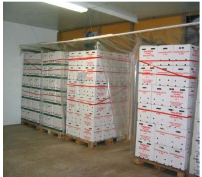
Kuva Oksasen Puutarha Oy:n pakotetun ilmankierron jäähdytystilasta.
