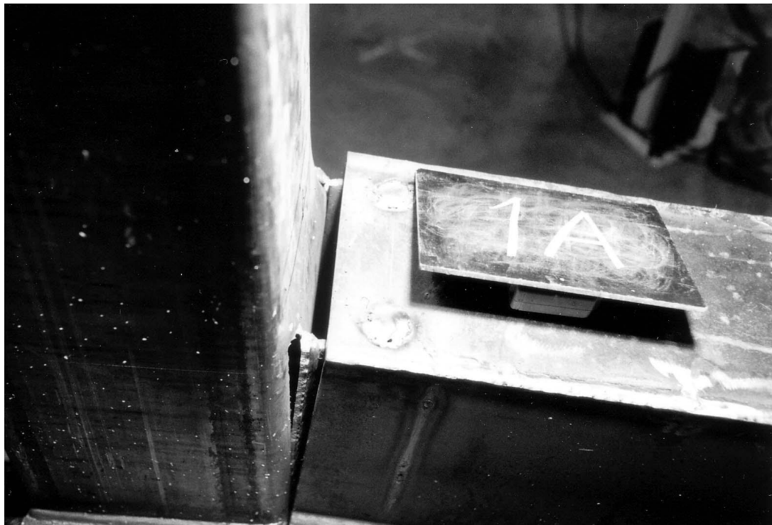
Kuva 17. Teräs ja leikkausrasitus. Konsolin irtoaminen pilarista taivutusmomentin vaikutuksesta, kun konsoli on liitetty ankkuroimatta putkiprofiilin kylmämuokkauksen vaikutusalueelle, ja palkin alapaarteen ja konsolin välitys on liian pieni /7/.
