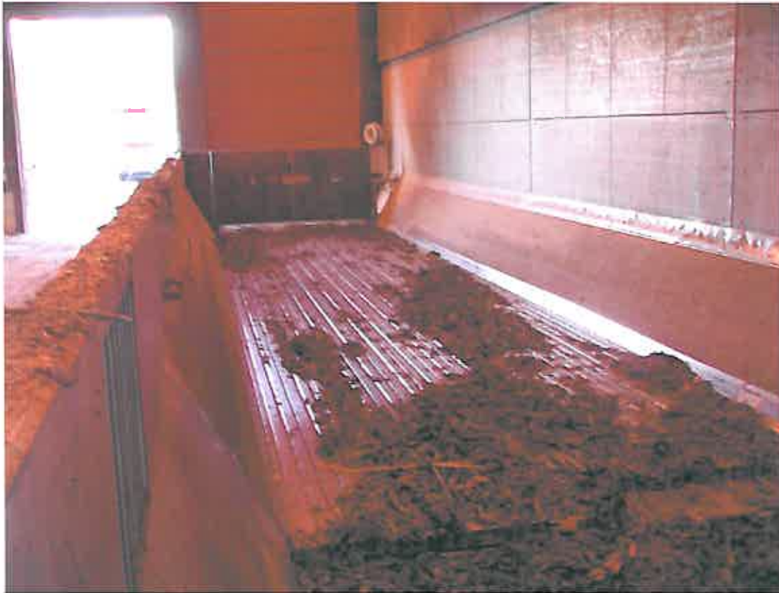
Kuva 6. Kävelevä lattia kuormien purkaukseen Jämsänkosken Voiman voimalaitoksella.
