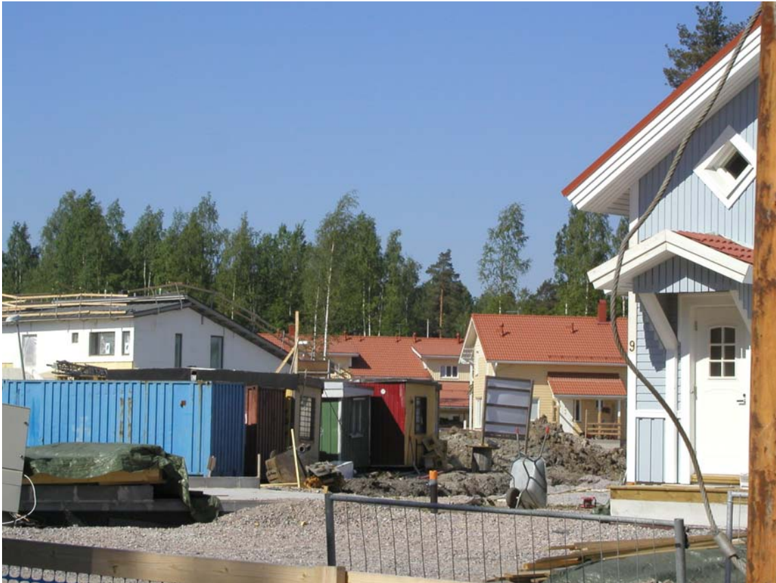
Kuva 6. Pientalojen aluerakentamisessa turvallisuus tulee suunnitella sekä maanpinnalle että vesikattotöihin.
