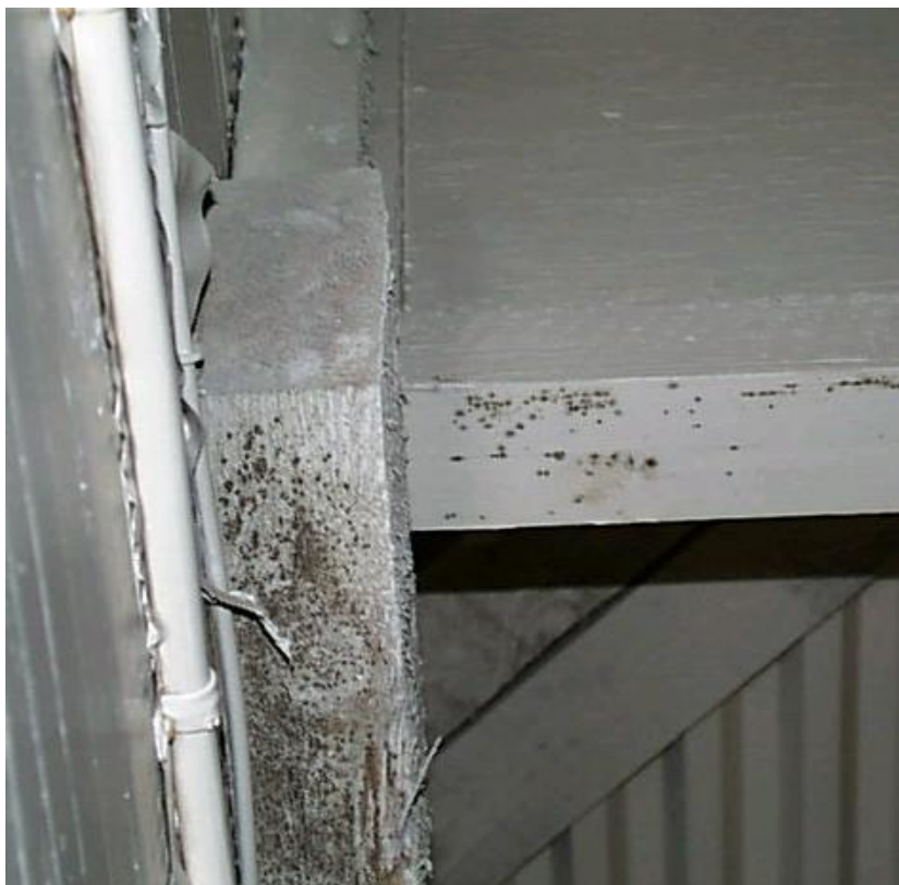
Kuva 2.4 Homeetta jäähallin liimapuurakenteissa. Puuosat on käsitelty homeenestomaalilla noin 2 vuotta aikaisemmin.
