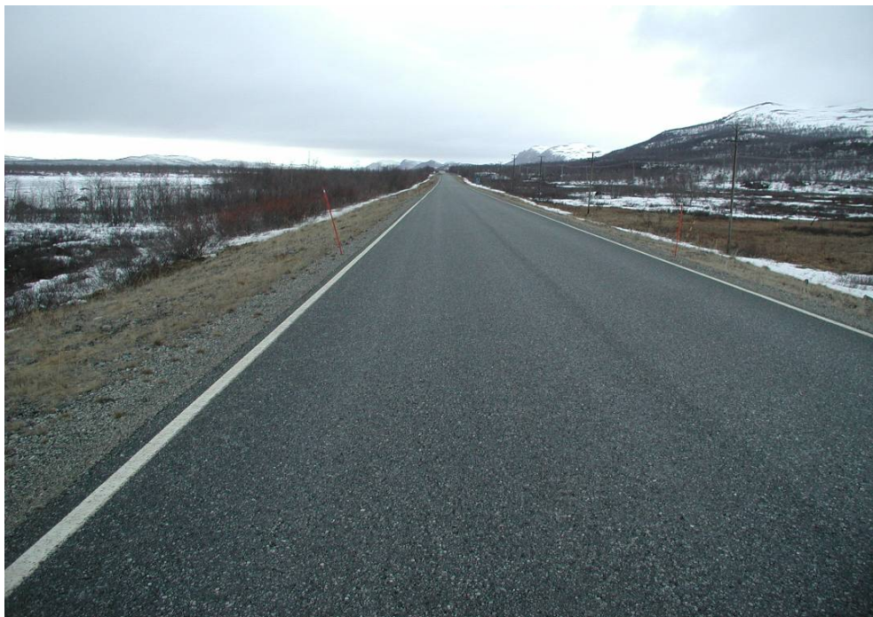
Kuva 5.2. Vt 21 Peera. Moreenikoerakenne plv. 30820 - 30920 keväällä 2007.
