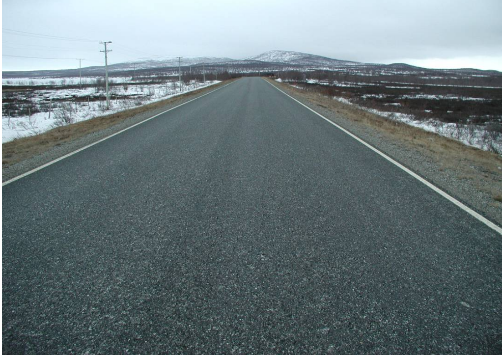
Kuva 5.3. Vt 21 Peera. Moreeni-sora-koerakenne plv. 30920 - 31100 keväällä 2007.
