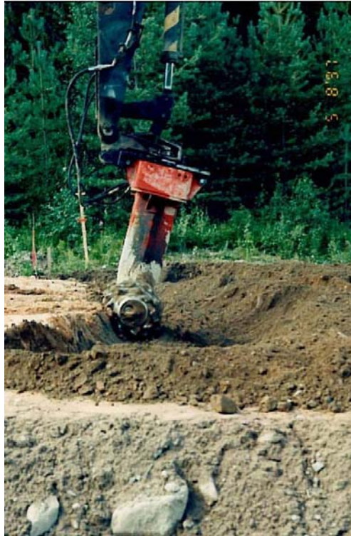
Kuva 5.11. Sideaineen sekoitusta alusrakenteeseen.
