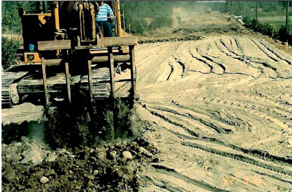
Kuva 5.7. Alusrakenteelle levitetyn sementin sekoittamista /Kvick 1997/.
