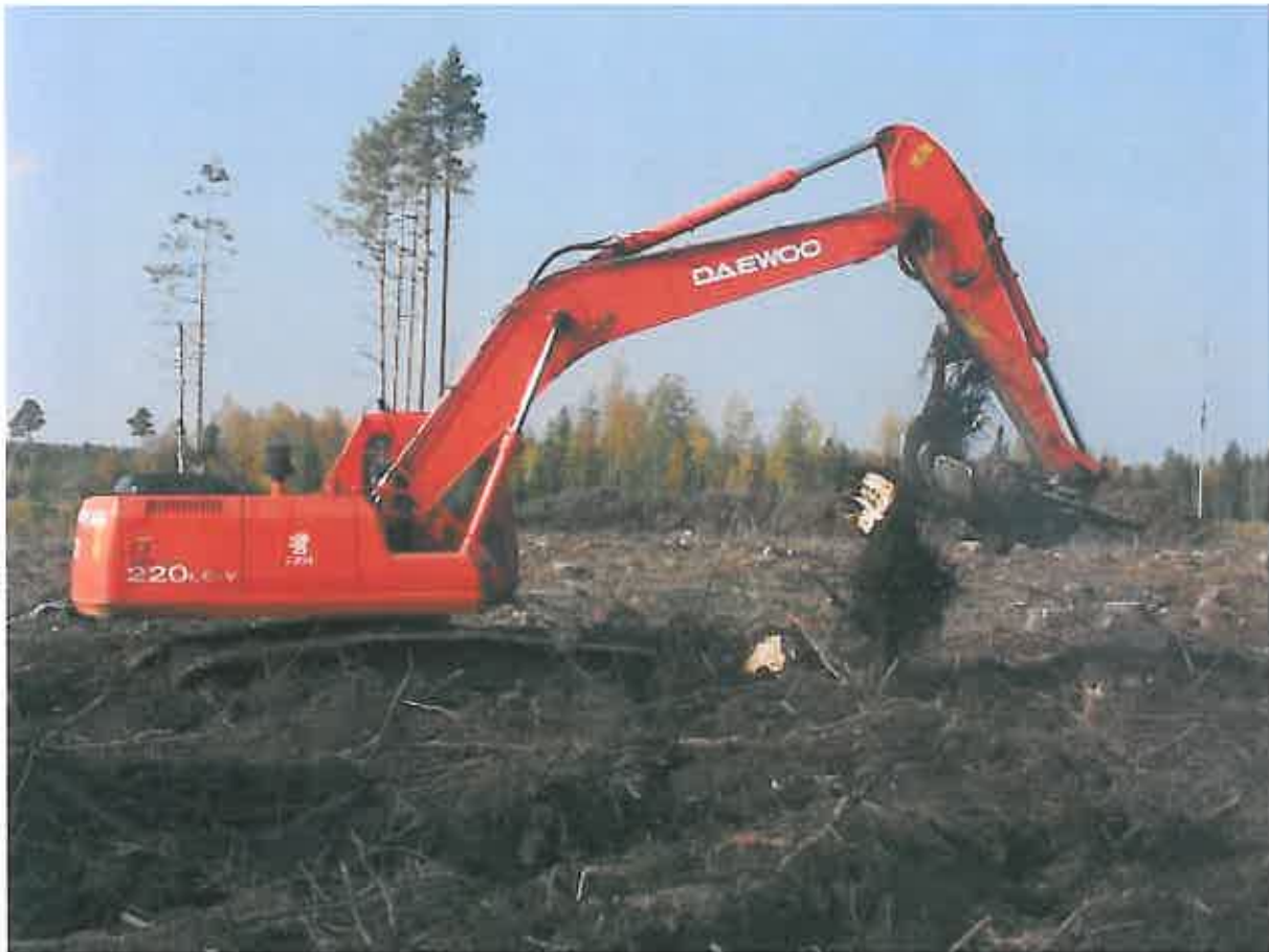
Kuva 4. Kantojen nosto käynnissä Jämsänkoscilla
