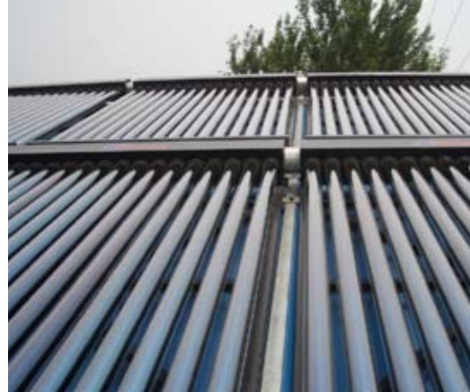
Tyhjöpötkitekniiikkaan perustuva aurinkokeräin. Kuva: Scandic Sunfi Oy
