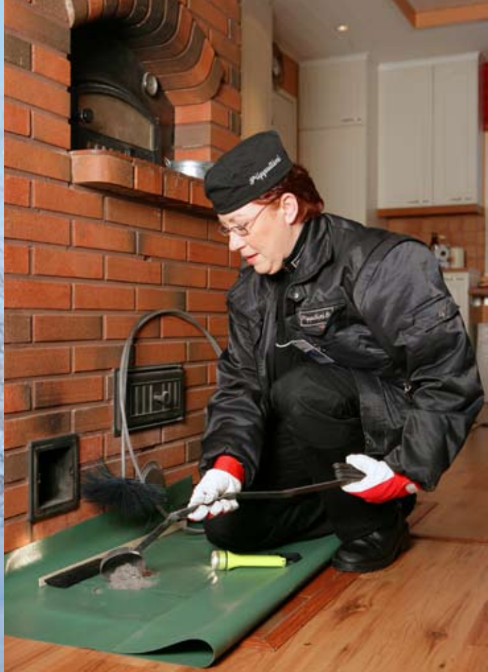
Nuohousvaijerien ja vaijeriharjojen avulla puhdistetaan tulisijan savunkierro. Jäykällä vaijerilla saadaan harjattua savunkierro huolellisesti. Nuohoojamestari Anne Aalto puhdistamassa tulisijaa. Kuvat: Pekka Mäkinen/Nuohousalan Keskusliitto
