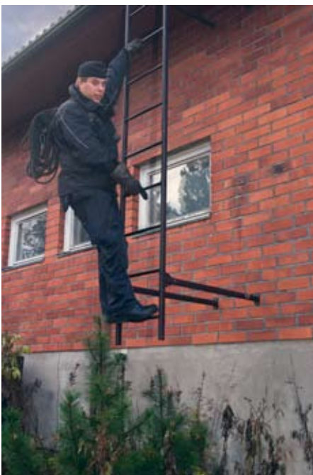
Nuohousvaijerien ja vaijeriharjojen avulla puhdistetaan tulisijan savunkierro. Jäykällä vaijerilla saadaan harjattua savunkierro huolellisesti. Nuohoojamestari Anne Aalto puhdistamassa tulisijaa. Kuvat: Pekka Mäkinen/Nuohousalan Keskusliitto
