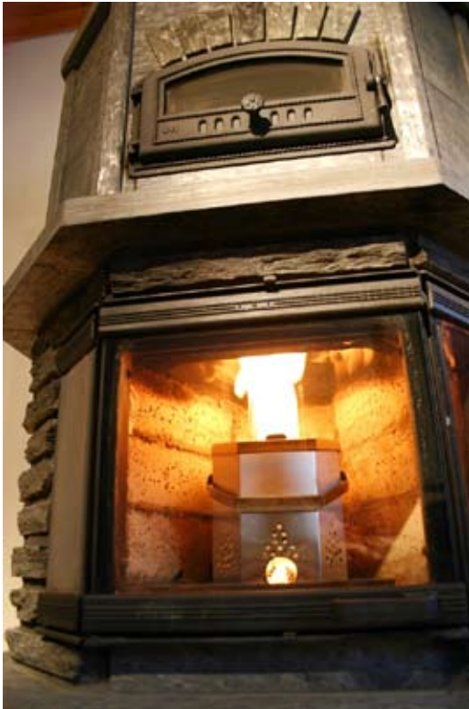
Pellettilaite asennettuna takka-leivinuunin tulisijaan. Tällaisessa laitteessa paloaika on useita tunteja. Kuva: Tulipiippu Ay
