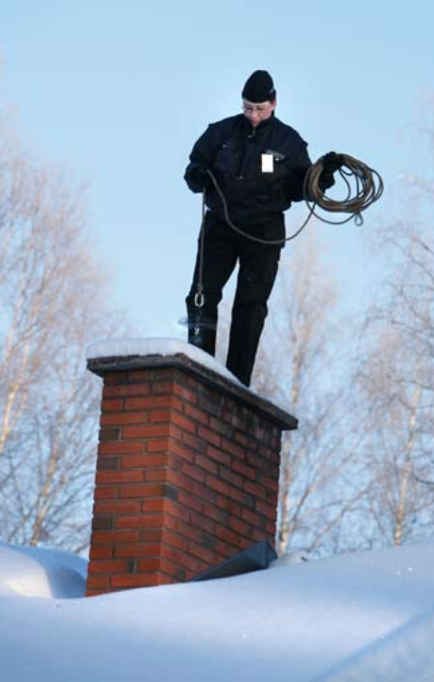
Nuohousvaijerien ja vaijeriharjojen avulla puhdistetaan tulisijan savunkierro. Jäykällä vaijerilla saadaan harjattua savunkierro huolellisesti. Nuohoojamestari Anne Aalto puhdistamassa tulisijaa. Kuvat: Pekka Mäkinen/Nuohousalan Keskusliitto
