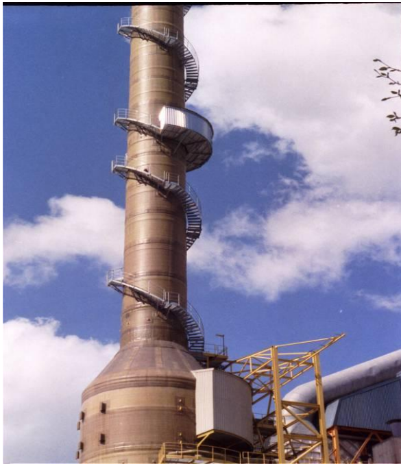
Kuva 6b. Mittauspaikka ja -suojarakennus savukaasupesurin jälkeen
