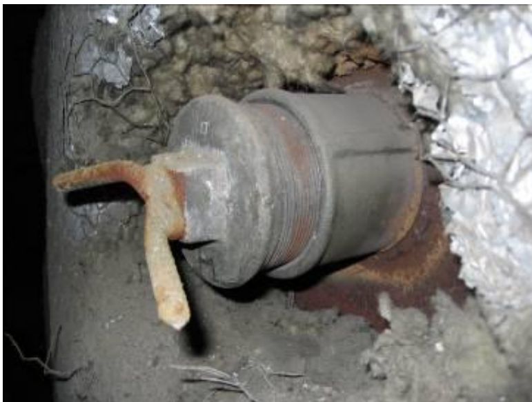
Kuva 10. Kiinniruostunut muhviyhde
