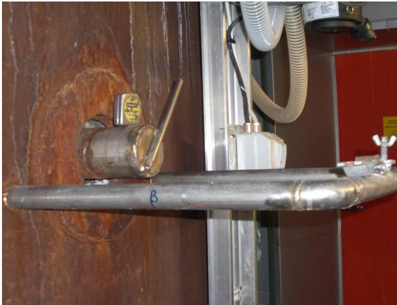
Kuva 11. Mittausyhteen alapuolelle hitsattu u-muotoinen sondituki
