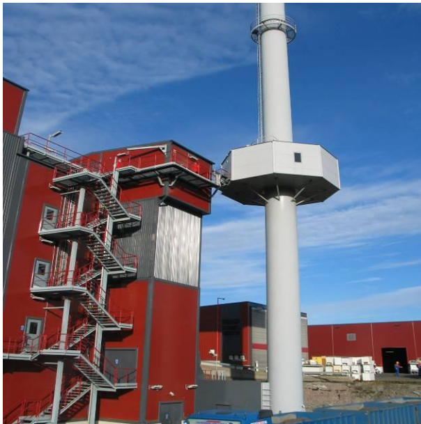
Kuva 5. Kulkureitti mittauspaikalle ja mittauspaikan suojarakennus
