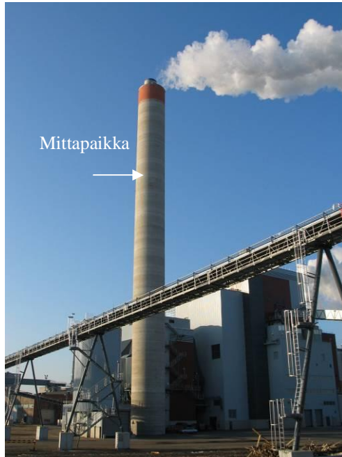
Kuva 1. Päästömittauspaikan sijainti voimalaitoksen piipussa
