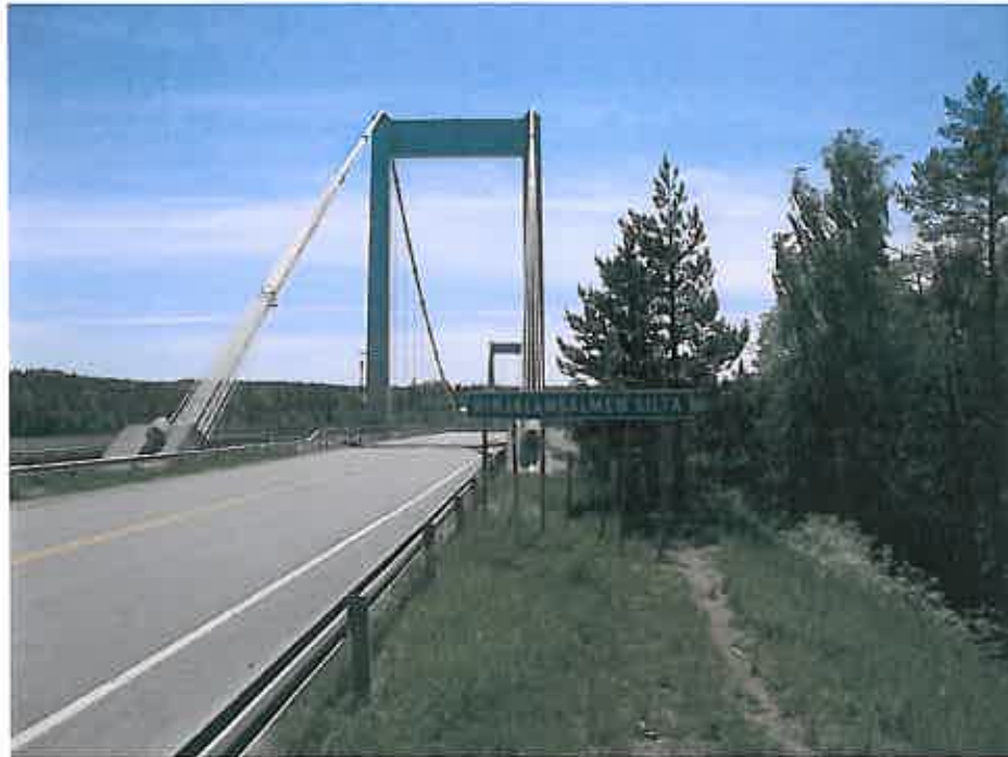
Figure 3.1. Kirjalansalmi suspension bridge in Parainen.
