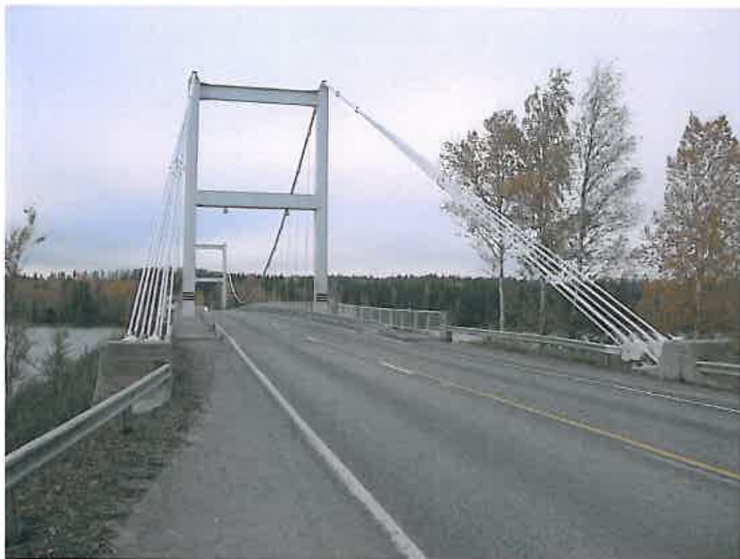
Figure 5.1. Hännilänsalmi suspension bridge in Viitasaari.
