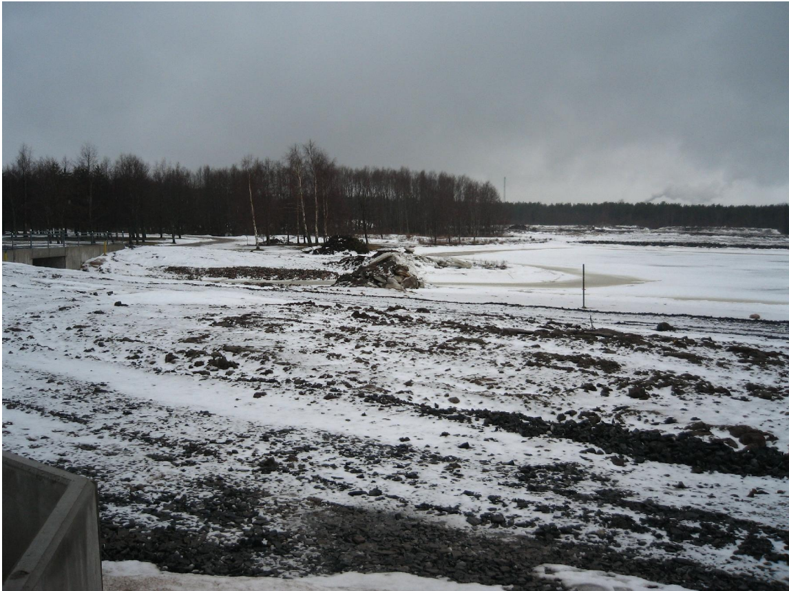
Kuva 10. Maanpintaa nostetaan tulevaa rakentamista varten. (Kuva: Irmeli Wahlgren)
