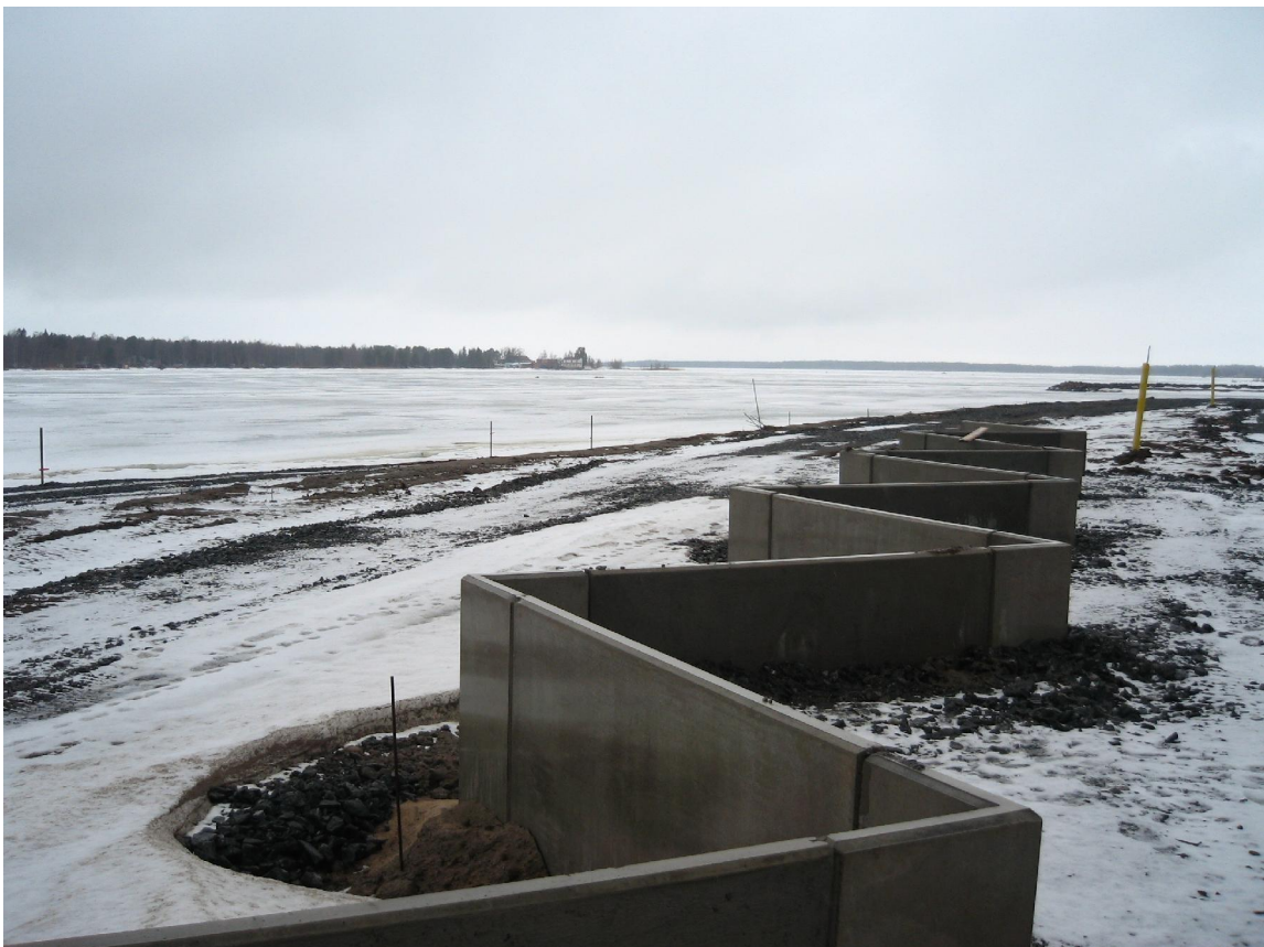
Kuva 11. Maanpintaa nostetaan tulevaa rakentamista varten. (Kuva: Irmeli Wahlgren)
