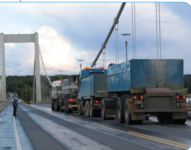
Figure 1. Kirjalansalmi suspension bridge in Parainen.
