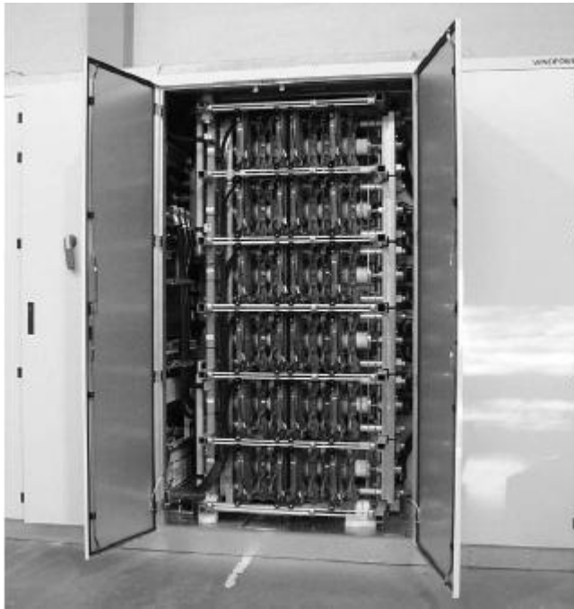
Kuva 32. Kuvan 31 taajuusmuuttajayksikön tasa- ja vaihtosuuntausosa [8].
