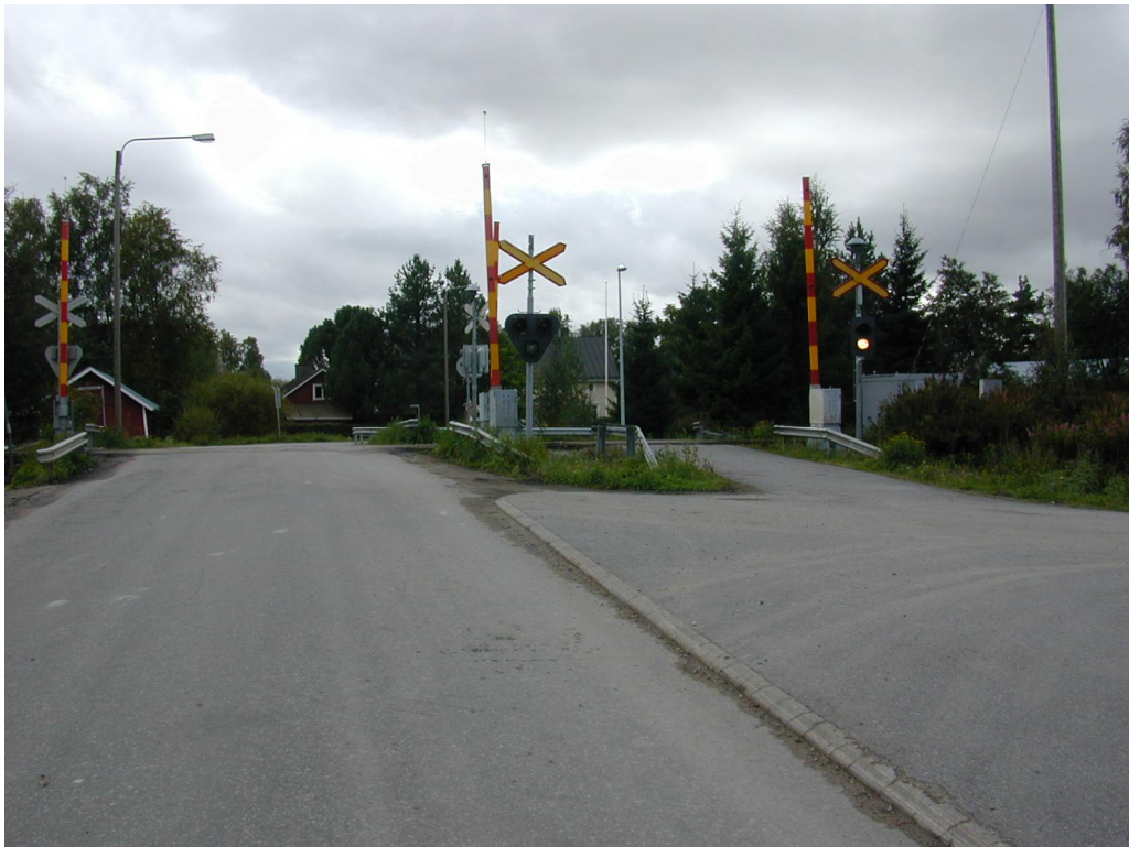
Kuva A-4. Laihia, aseman ylikäytävä
