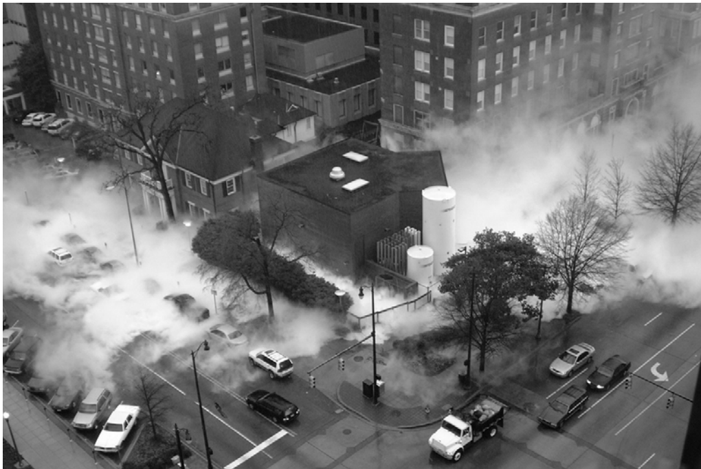
Kuva 3. Sairaalan nestehappisäiliön tyhjennettyä muodostunut sumupilvi. Ilman lämpötila oli 13 °C ja suhteellinen kosteus lähes 100 % (Schumacher ym. 2004).
