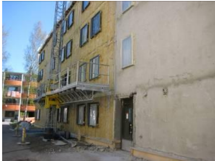
Kuva 17. Alkuperäisen lämmöneristyksen poistamisen jälkeen sisäkuoren pinta voidaan oikaista ja tasoittaa laastilla.
