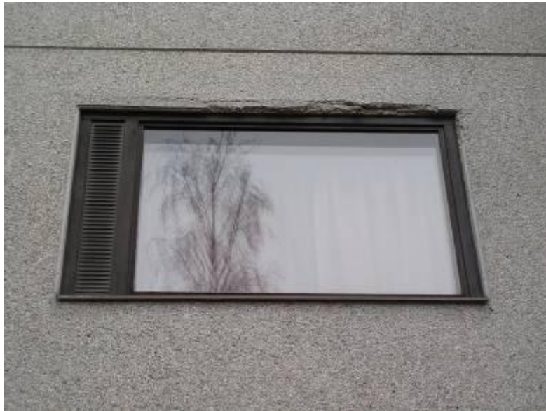
Kuva 10. Pakkasvaurioita ikkunan liitosrakenteissa.
