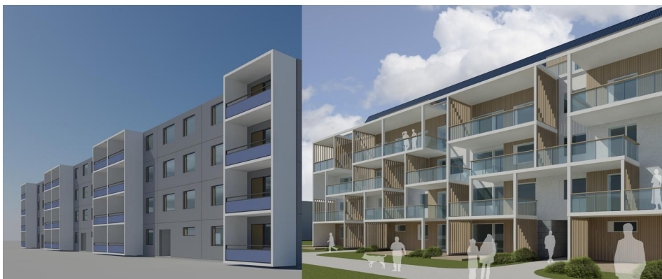
Kuva 26. Vanha ja uusittu, lisäeristetty julkisivu /8/.
