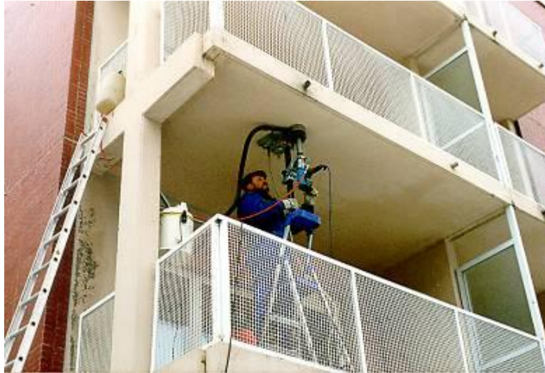
Kuva 27. parvekelaatan alapinnan hiekkapuhallus.
