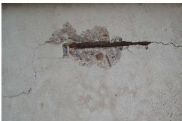
Kuva 10. Pakkasvaurioita ikkunan liitosrakenteissa.
