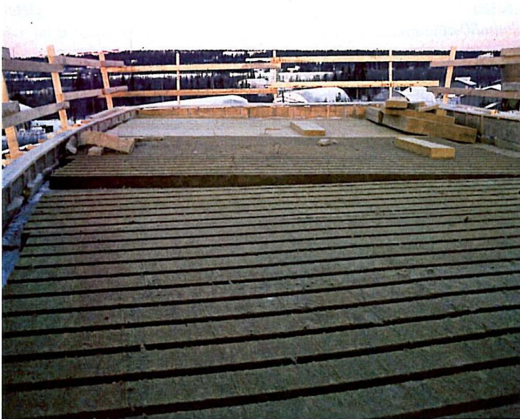
Kuva 33. Uritetun lämmöneristeen avulla tuuletettu loiva katto.
