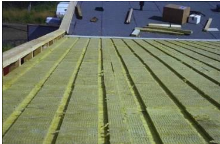
Kuva 29. Nykyisin useimmiten loivan katon (kaltevuus \leq 1 : 20 ) eristys toteutetaan urien tuulettavana lämmöneristyksenä.
