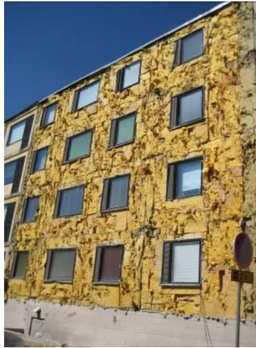
Kuva 16. Julkisivun purkamisen jälkeen poistetaan vanha lämmöneristys
