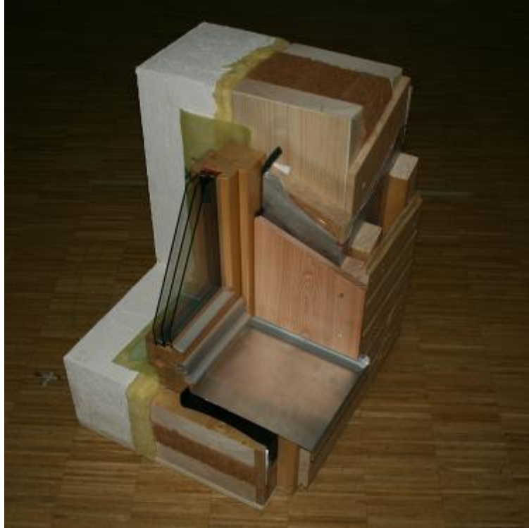
Kuva 25. Lisälämmöneristäminen betonielementin sisäkuoren pintaan puurakenteisella TES-elementillä /7/. Lisäeristysrakenteeseen voidaan reitittää myös uusittavat talotekniset asennukset.
