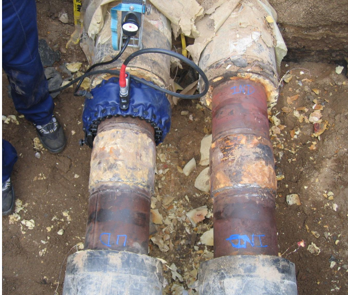
Kuva 14. Guided Ultrasonics Ltd:n panta kiinnitettyinä kaukolämpöputkeen Bredgadella Kööpenhaminassa (Bertelsen, 2010).
