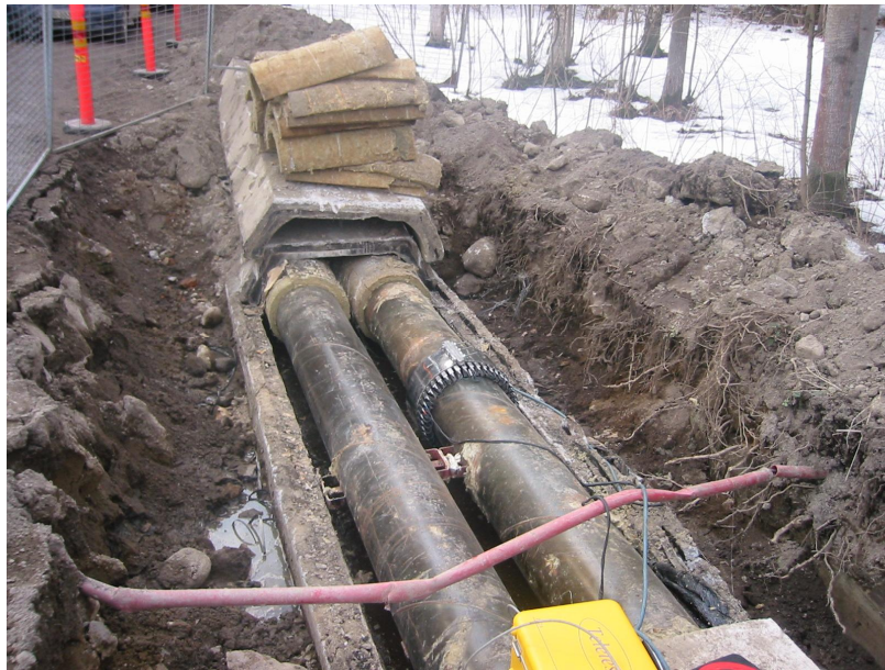
Kuva 12. Anturipanta kiinnitettyä paluuputkeen (cool pipe) Lepolantiellä (Edwards, 2005).
