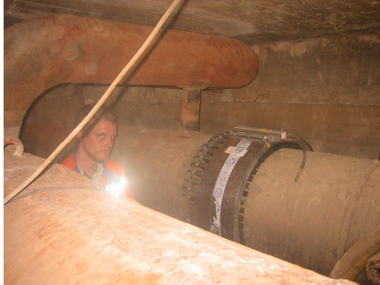
Kuva 10. Anturipanta kiinnitettynä paluuputken (cool pipe) päällä Yliopistokadulla (Edwards, 2005).
