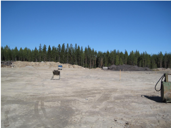
Kuva 5. Polttoaineterminaalikentän tasoitus on tehty ennen asfaltointia ja laitteiden asennustyöt on aloitettu asfaltoinnin jälkeen Pihtiputaan terminaalilla.
