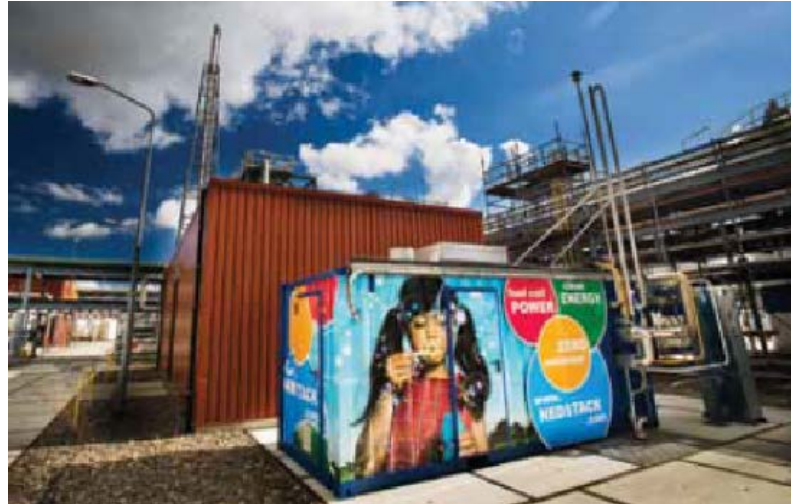
Kuva 3.6. PEM polttokenno Akzo Nobelin kloorialkalitehtaalla [Nedstack].
