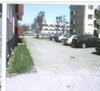
Figur 7.20 Parkeringsytan är försedd med en gräsbevuxet rasteryta. Rasterytan är av betong. Sölgatan, Växjö.
