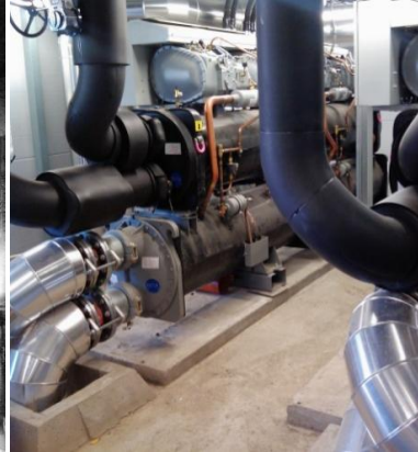
MEGAWATIN LÄMPÖPUMPPU. KUVA: ASMO HUUSKO, GTK
