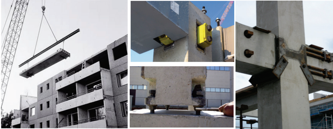
Kuva 10. Myös betonirungon osia voidaan käyttää uudelleen, etenkin jos liitokset suunnitellaan nykyistä helpommin purettaviksi.
