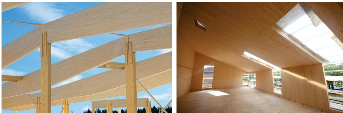
Kuva 11. Liimapuupalkit sekä CLT-laatat sopivat hyvin uudelleenkäyttöön
