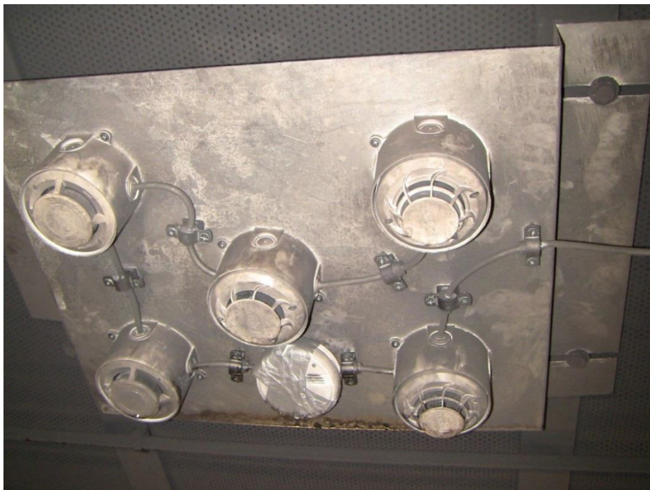
Kuva 9. Paloilmaitinlevy kiinnitettynä Paloteatterin polttotilan välikattoon. Ilmaisimien asennus levyyn on laitetöimittajan tekemä.
