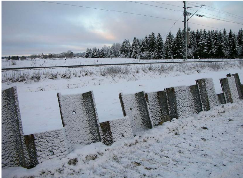
Kuva 1. Tärinävaimennusseinä Loimaan koekohteessa talvella 2005–2006 (Poikolainen 2006a).
