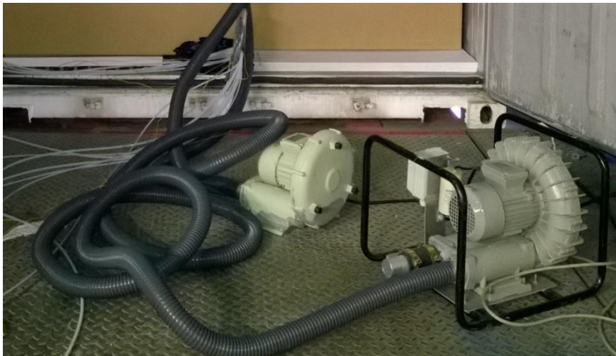
Kuva 6. Sivukanavapuhaltimet ja tiiviisti lastatun kontin lattian tiivistystapa taustalla.
