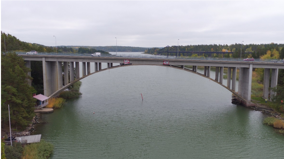
Kuva 3. Hessundinsalmen silta, Parainen, Varsinais-Suomi.
