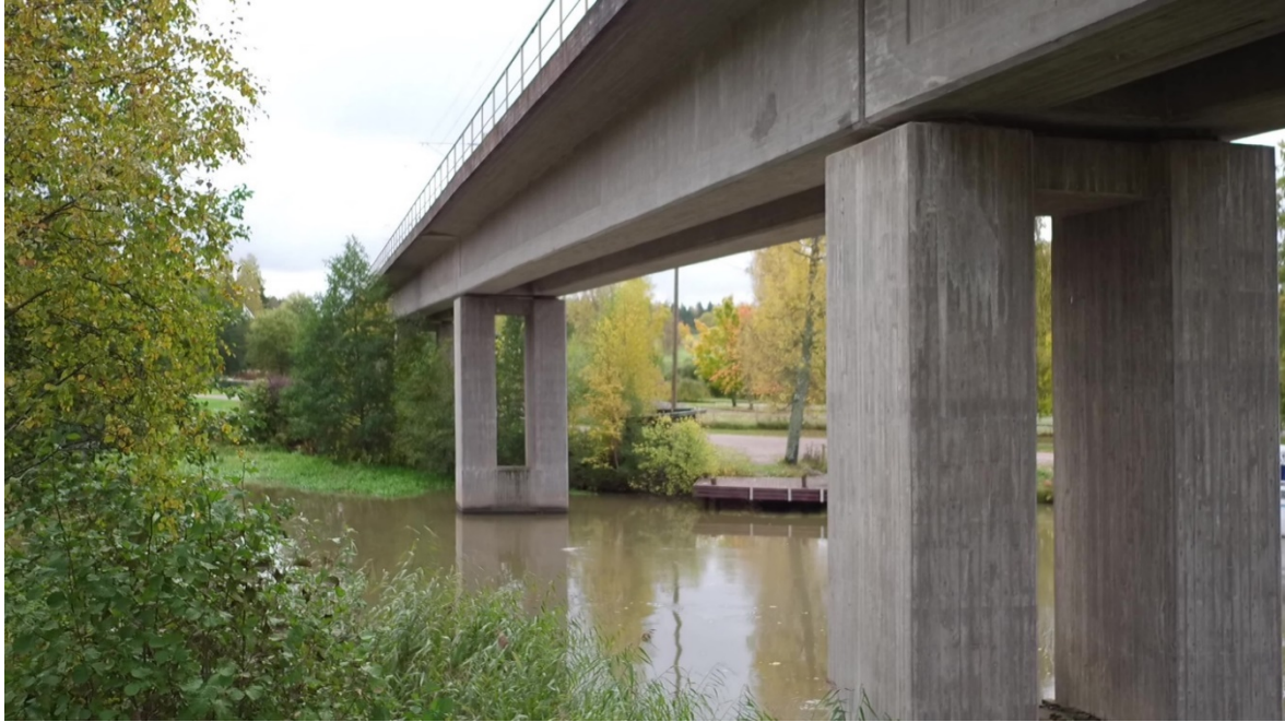
Kuva 4. Mustionjoen ratasilta, Raasepori, Uusimaa.
