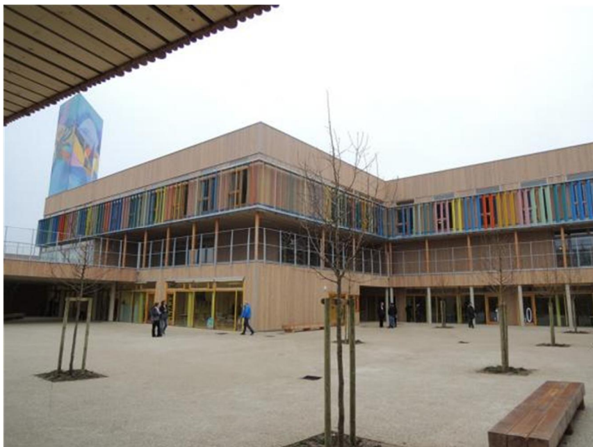
Kuva 15. Puurakenteinen koulu Ranskan Limeill-Brevannesissa. (Arkkitehdit Veronique Klimine ja Olavi Koponen). (Puuinfo 2017).
