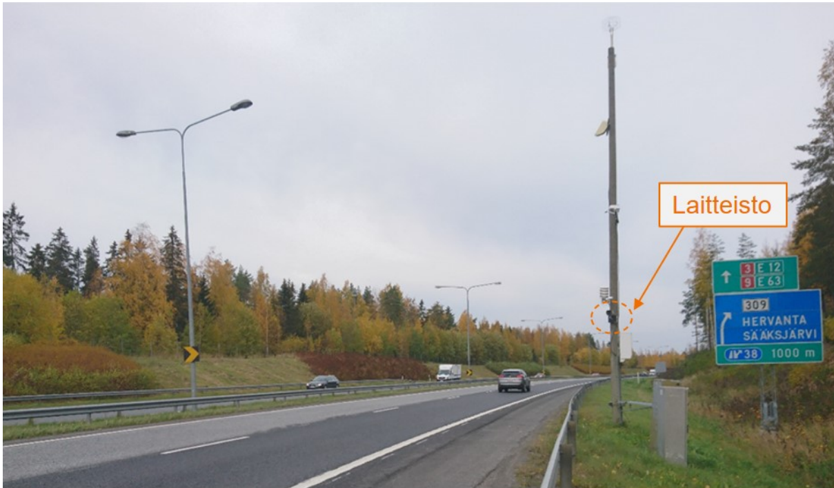
Kuva 11. Kuva asennetusta laitteistosta.
