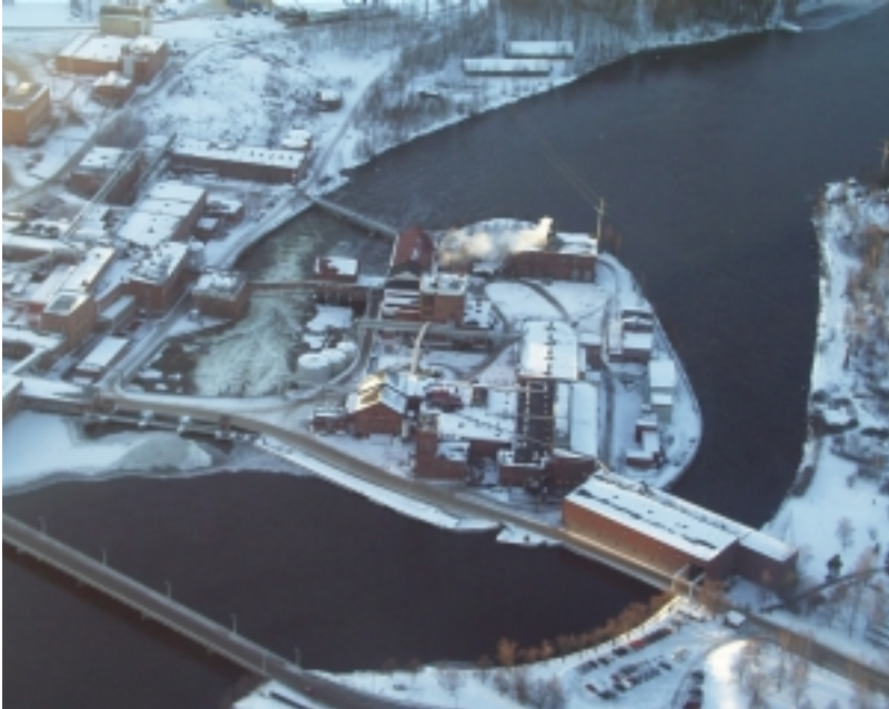
Kuva 9. Kuusankosken voimalaitos talvella 1998–1999 ylävirranpuolelta kuvattuna. Voimalaitos ja sen alakanava ovat kuvan oikeassa reunassa.
