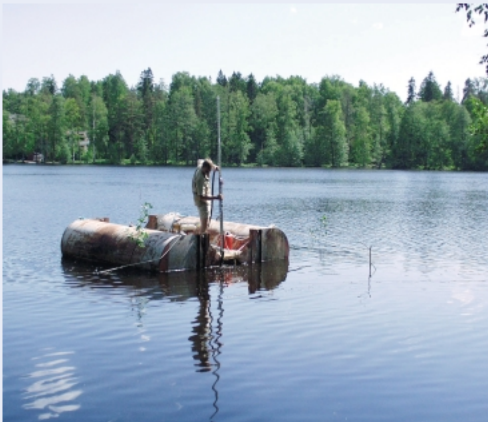
Pohjan tiivistyskokeilua täryttämällä kesäkuussa 2002.
