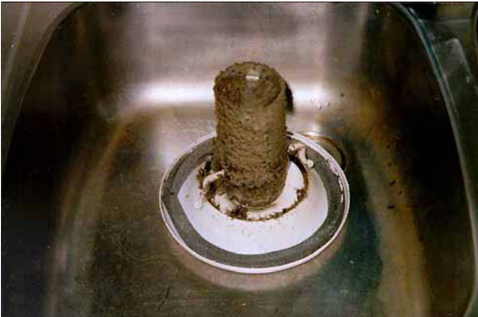
Kuva 15. Likainen koneellisen poistoilmanvaihdon poistoilmaventtiili.
