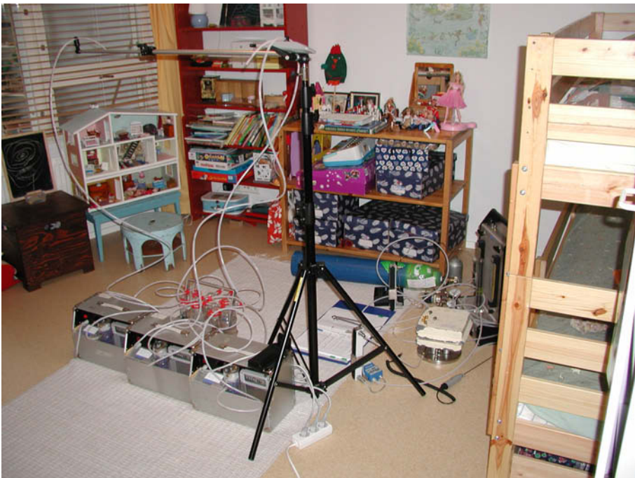
Kuva 2. Sisäilma- ja emissiomittaus ennen korjaustoimenpiteitä ongelmakohdassa 1.
