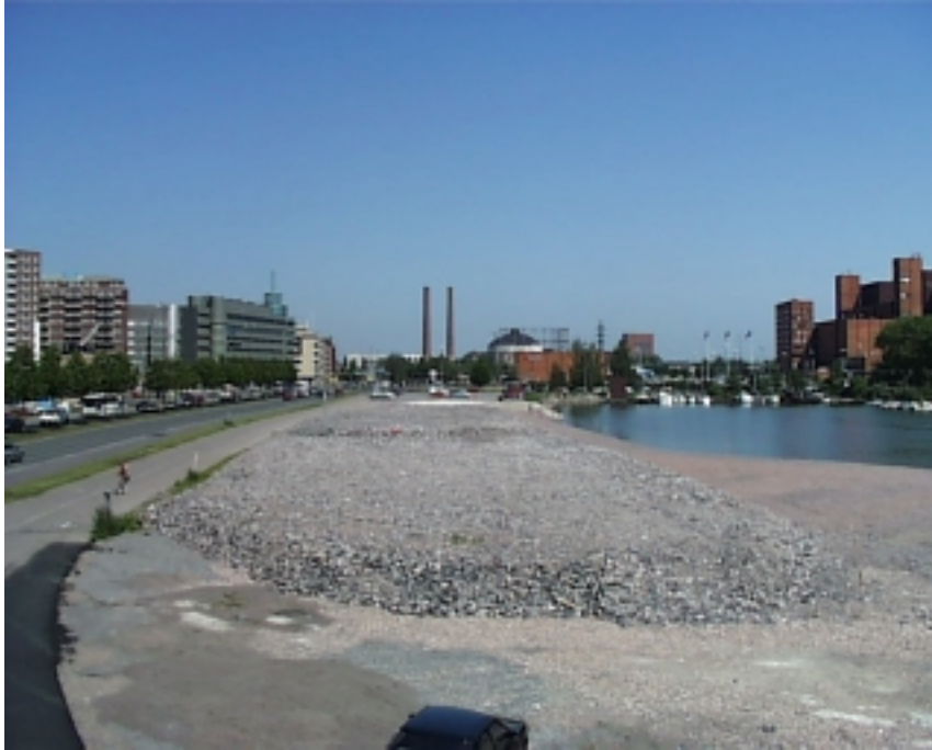
Figure 5. Preload embankment on the mass stabilised mud in Sörnäinen, Helsinki.
