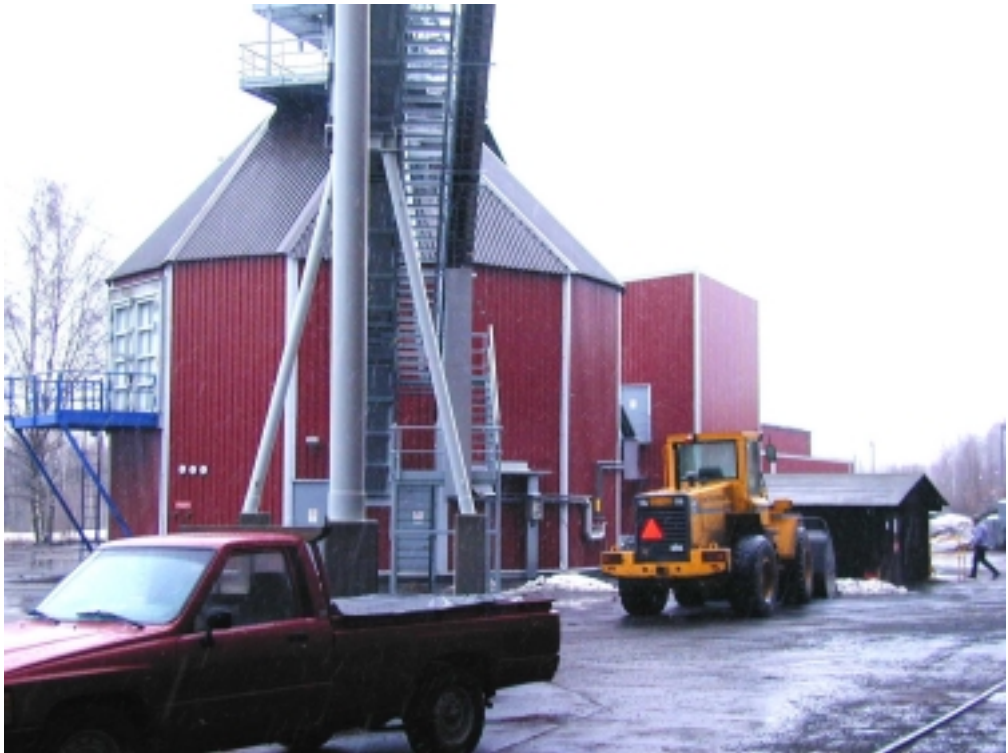
Kuva 2. Fortum Hämeenlinnan voimalaitoksen syöttölinjaa, etualalla väli-varasto.
