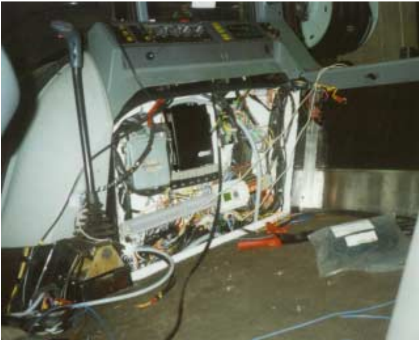
Kuva 3. Sähkötyöt ja uuden logiikan asennustyöt meneillään.
