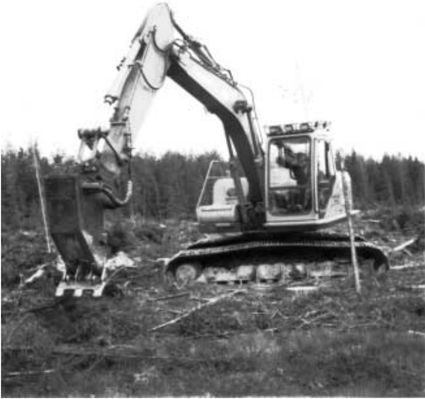
Kuva 2. Daewoo 130 LC-W Solar XT -kaivukone ja urakoitsija Eero Karhun käyttämä mätästyslaite.
