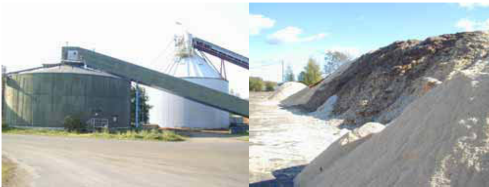
Kuva 6. Vasemmalla: Simpeleen voimalaitoksen välivarastot jyrsinturpeelle ja puupolttoaineille. Oikealla: Metsäteollisuuden sivutuotteita varastoituna Mikkelin Pursialan laitoksen pihalle viikonlopun käyttöä varten.
