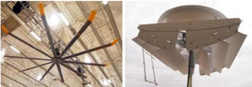
Kuva 125. Kesäaikaiseen viilennykseen on valittavissa myös kattoon sijoitettava helikopterisekoitin. Jos kantavat rakenteet estävät helikopterin, kattoon on saatavissa sivuille heittävä tehopuhallin, johon voidaan tarvittaessa yhdistää kostutus-suuttimet.
