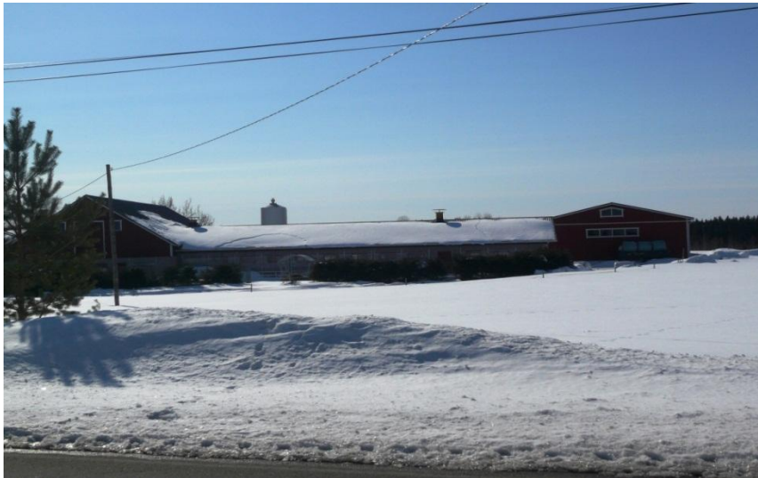
Kuva 85. Kohdetila ulkoa katsoen.
