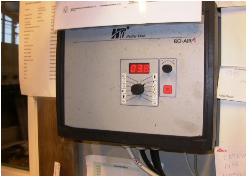
Kuva 48. Ilmanvaihtoa säädetään BO-AIR-säätölaitteilla.
