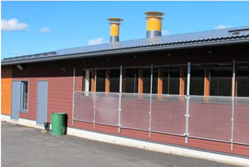
Kuva 133. Kennolevyalueen kiinteä alaosa on verhottu vaakasuuntaisella puulla.
