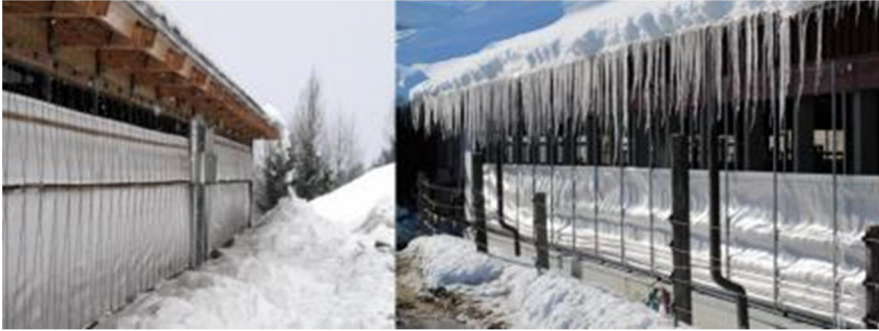
Kuva 131. Pitkät räystäät suojaavat lumen ja jääpuikkojen aiheuttamilta vahingoilta.
