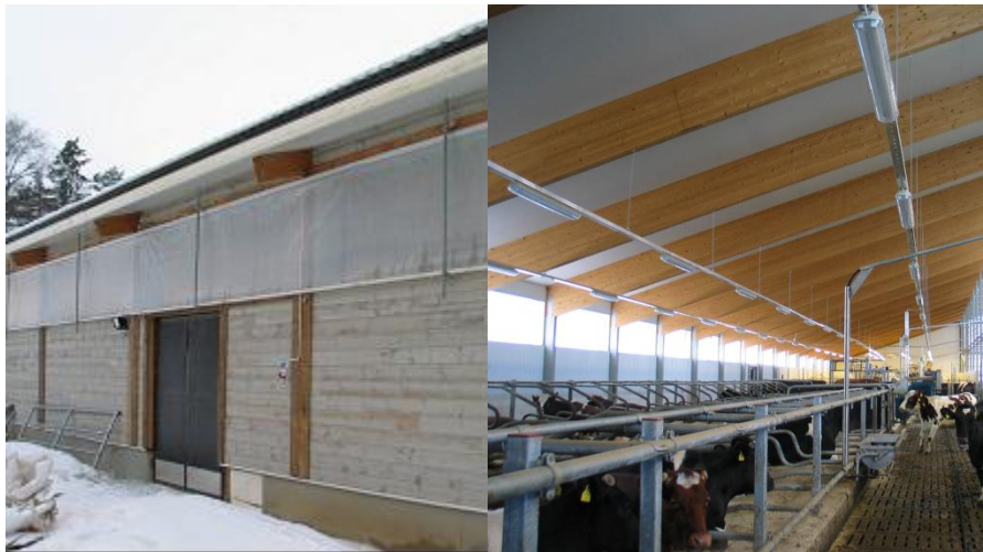
Kuva 1. Eräs verhoseinäilmanvaihdolla toteutettu lypsykarjarakennus (Kivinen et al. 2006).
