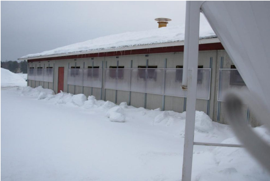
Kuva 87. Kennoseinä on auki yläreunastaan noin 10 cm.
