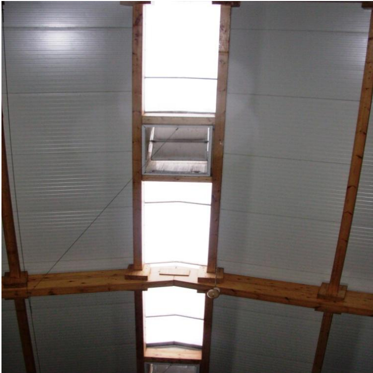
Kuva 49. Poistoilmaluukku katossa.
