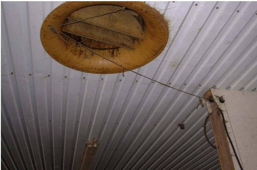
Kuva 88. Poistoilmahormi katossa.
