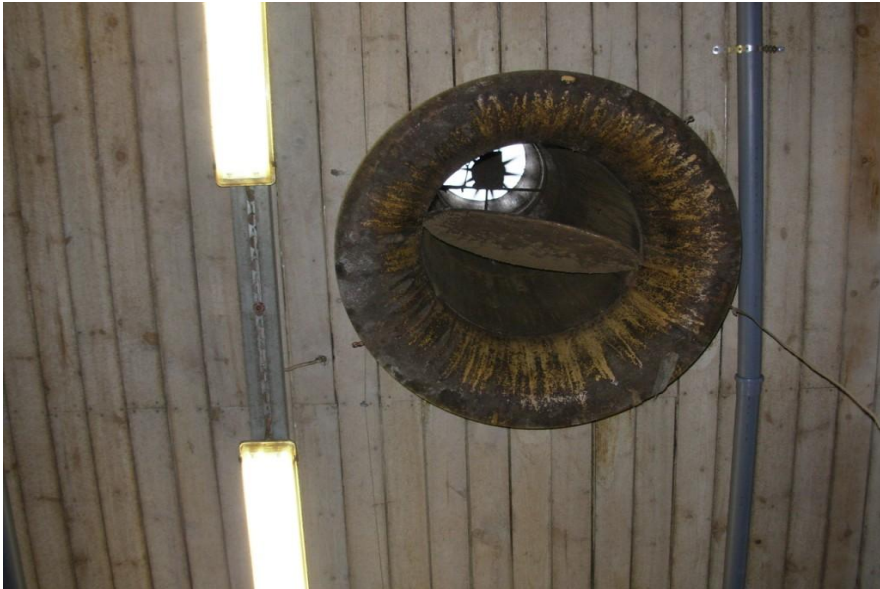
Kuva 113. Poistoilmahormi katossa.
