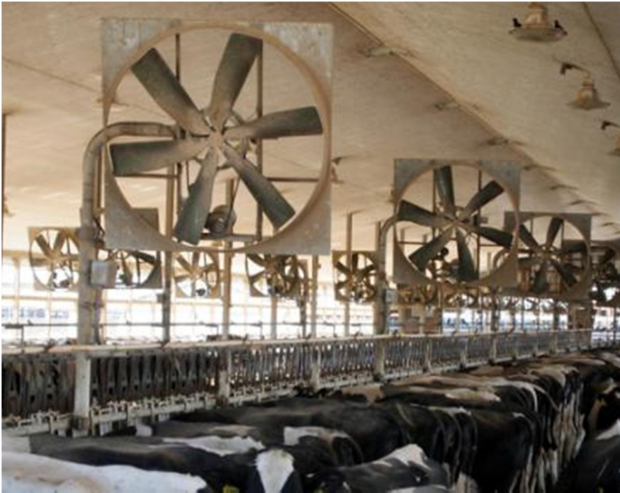
Kuva 124. Vaakapuhaltimet sijoitetaan ruokintapöydän suuntaisesti ja käännetään puhaltamaan alaviistoon. Puhaltimien välinen etäisyys on kymmenen kertaa puhaltimen halkaisija.
