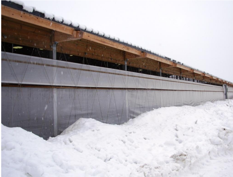
Kuva 46. Verhoseinä talvella. Yläverhon tuloilma-aukko on auki noin 25 cm.
