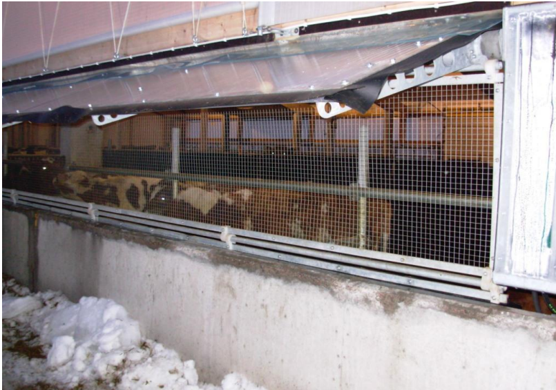
Kuva 79. Sivuseinän alareunassa ruokintakourussa on visiirilukut, joita voidaan kesällä käyttää ilmanvaihdon tehostukseen.
