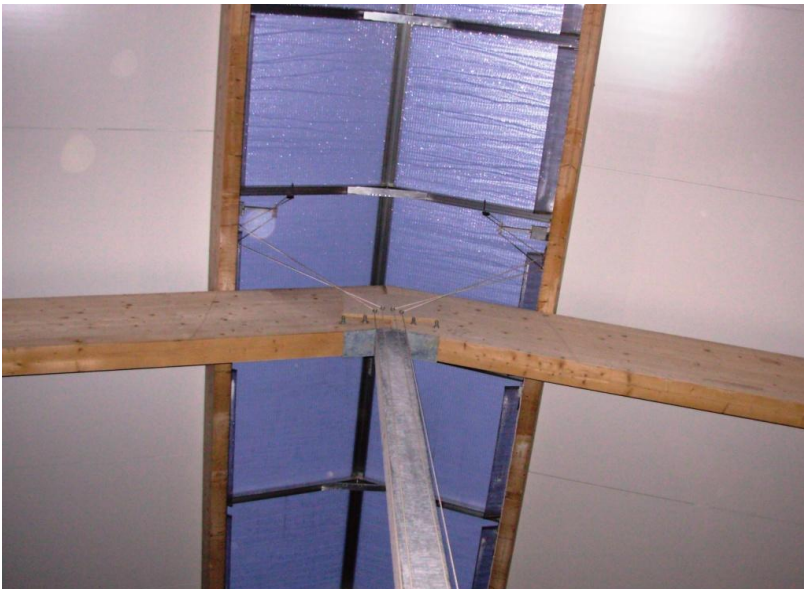
Kuva 78. Poistoilma johdetaan ulos katon harjassa olevien aukkojen kautta.
