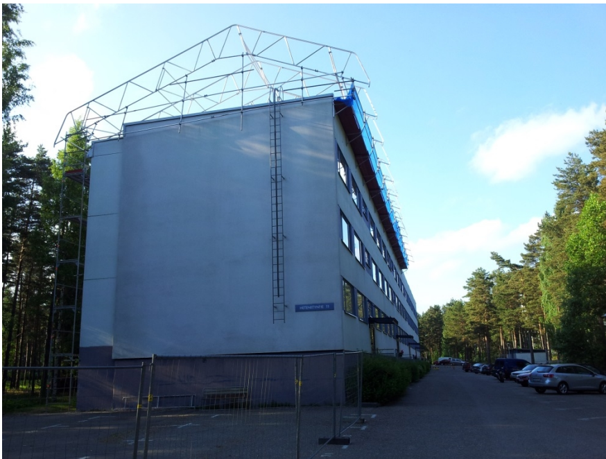
Kuva 76. Kerrostalon kattosuojauksen rakentamisvaihe.
