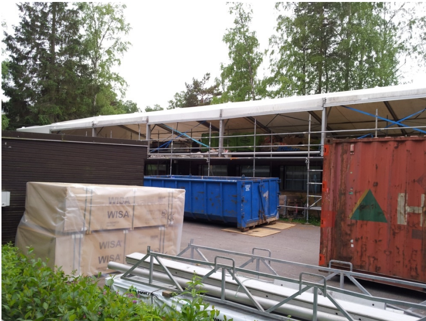
Kuva 74. Rivitalon kattokorjauksessa koko katto on sääsuojattu. Osa materiaaleista on varastoitu sääsuojan alle, osa suojattuina ulos.
