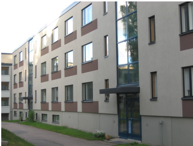
Kuva 67. Vanha rakennus yllä ja rakennus peruskorjauksen jälkeen alla.
