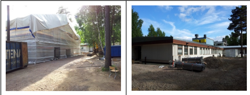
Kuva 75. Koulurakennuksen suojaus korjausvaiheessa (vasen kuva) ja rakennuksen korjattu osa (oikeanpuoleinen kuva).
