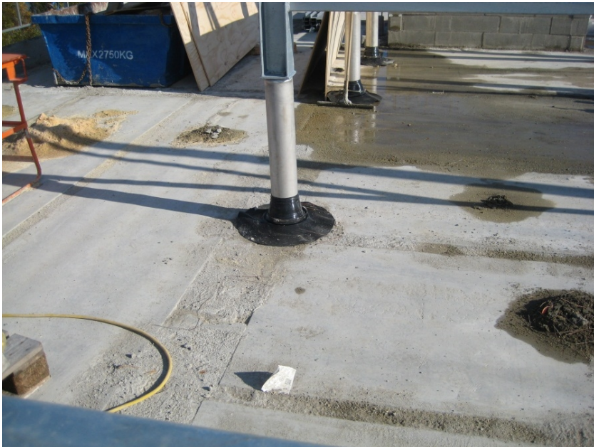
Kuva 4. Tuuletetun alapohjan saumojen tiivistäminen betonivalulla. Menetelmän riskejä ovat työn laadun varmistaminen ja massan ja elementtien ja massan tartunta elementteihin ja tartunnan puutteesta syntyvät raot.
