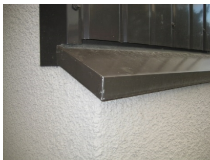
Kuva 9. Esimerkkejä suojaPELLITYKSISTÄ. Yllä sisäänkäyntikatoksen räystääspellityksen nurkka, keskellä nurkkapilasterin suojaPELLITYS (vasen) ja läpivientejä kallistettuna ulospäin julkisivusta (oikea) sekä alla ikkunapellin pään liittyminen julkisivuun (vasen) ja ulkonevan julkisivun suojaPELLITYS peltiverhouksen alapuolella (oikea).
