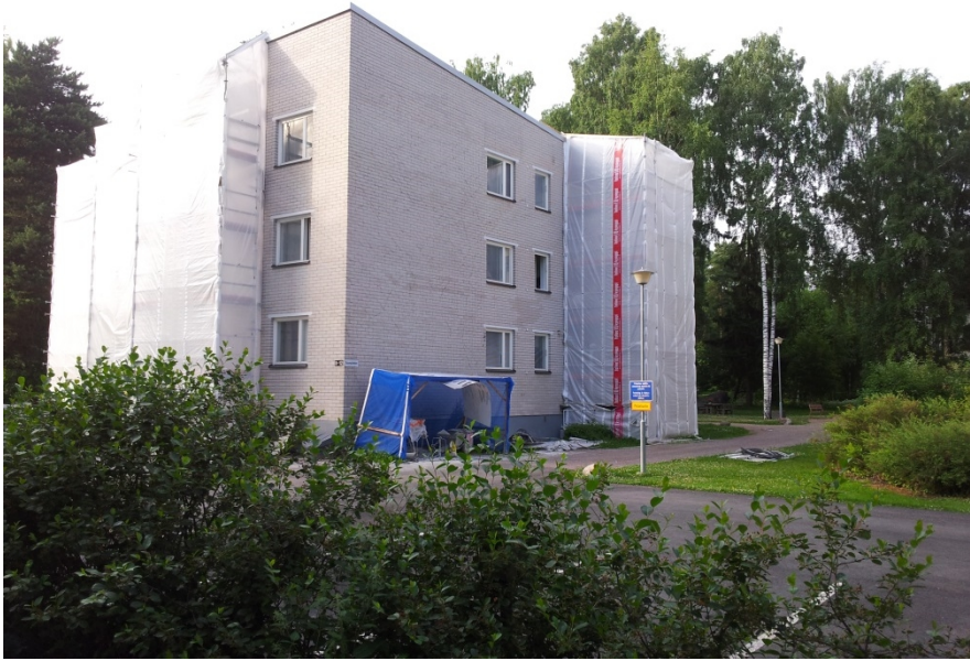
Kuva 77. Tarkoituksenmukainen suojaus parvekesaneeraustyömaalla.
