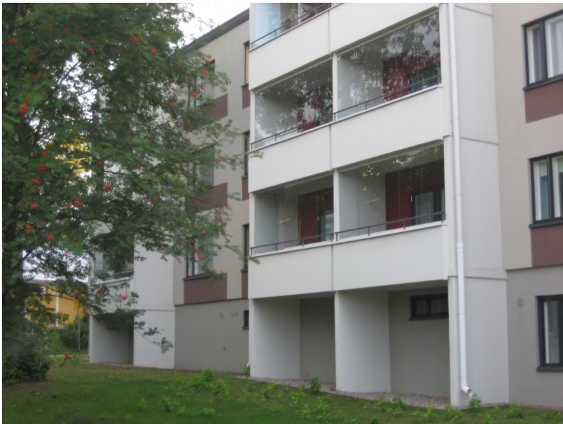
Kuva 68. 1970-luvun kerrostalo ennen peruskorjausta (yllä) ja peruskorjauksen jälkeen (alla).
