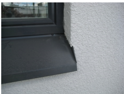
Kuva 9. Esimerkkejä suojaPELLITYKSISTÄ. Yllä sisäänkäyntikatoksen räystääspellityksen nurkka, keskellä nurkkapilasterin suojaPELLITYS (vasen) ja läpivientejä kallistettuna ulospäin julkisivusta (oikea) sekä alla ikkunapellin pään liittyminen julkisivuun (vasen) ja ulkonevan julkisivun suojaPELLITYS peltiverhouksen alapuolella (oikea).
