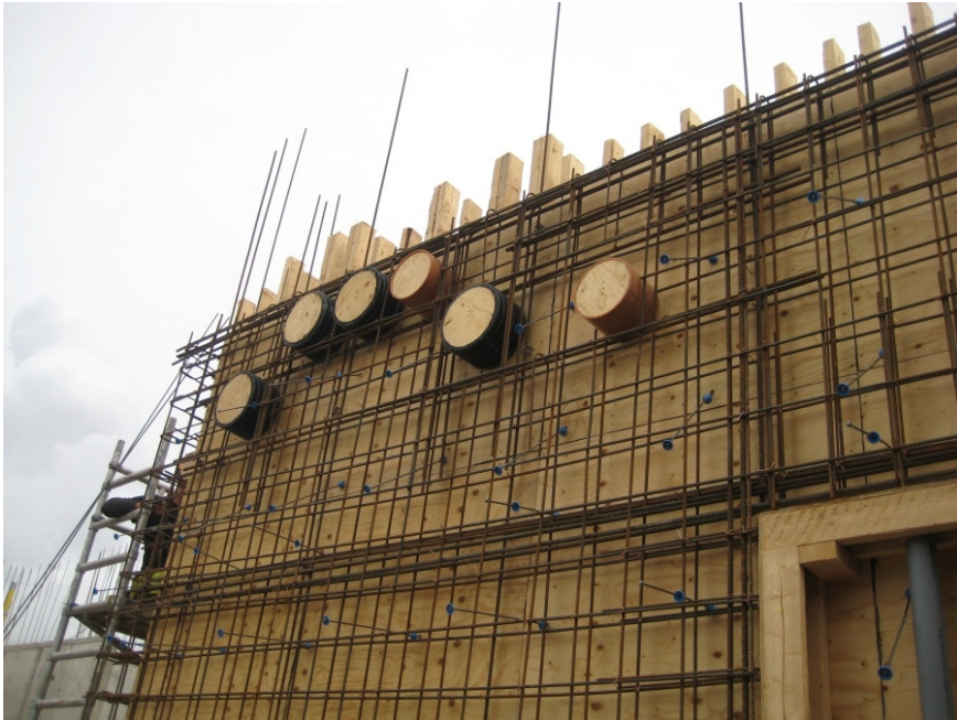
Kuva 5. Suurten läpivientien tiivistäminen läpivientikappaleilla.
