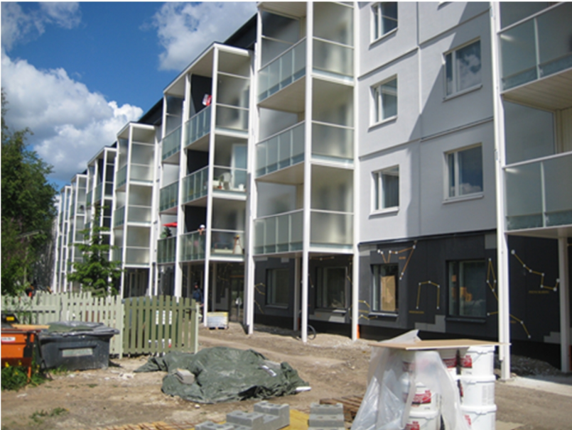
Kuva 66. Peruskorjausta odottava rakennus (yllä) ja sama rakennus korjauksen lopussa (alla).
