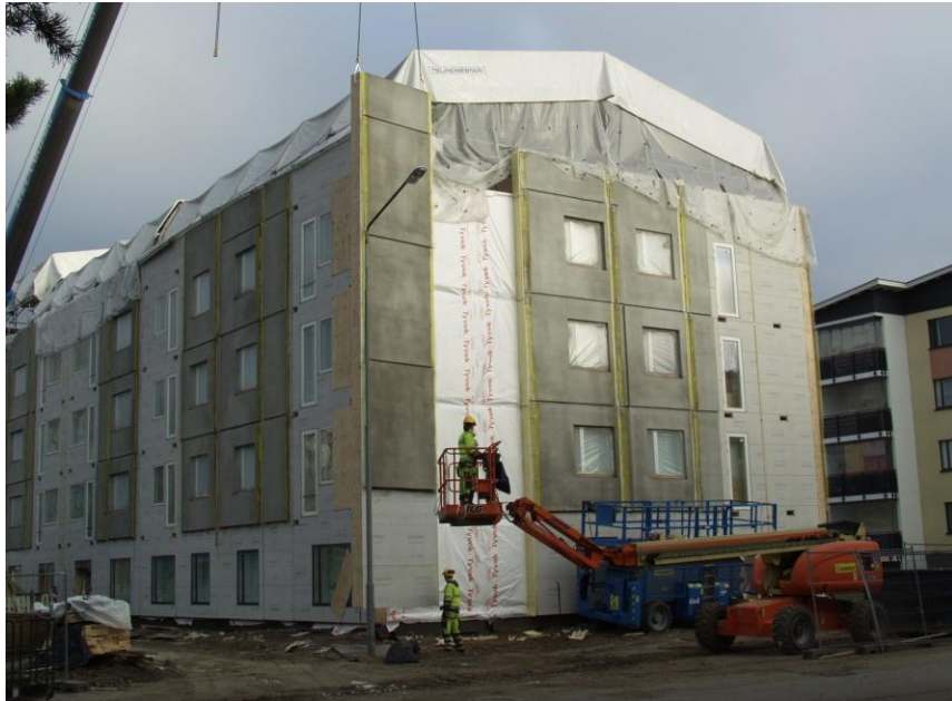
Kuva 21. Rakennuslevyt osittain asennettu.
