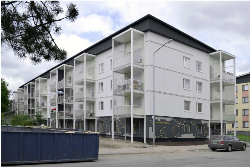
Kuva 22. Valmis kohde kadun puolelta (10.7.2012).
