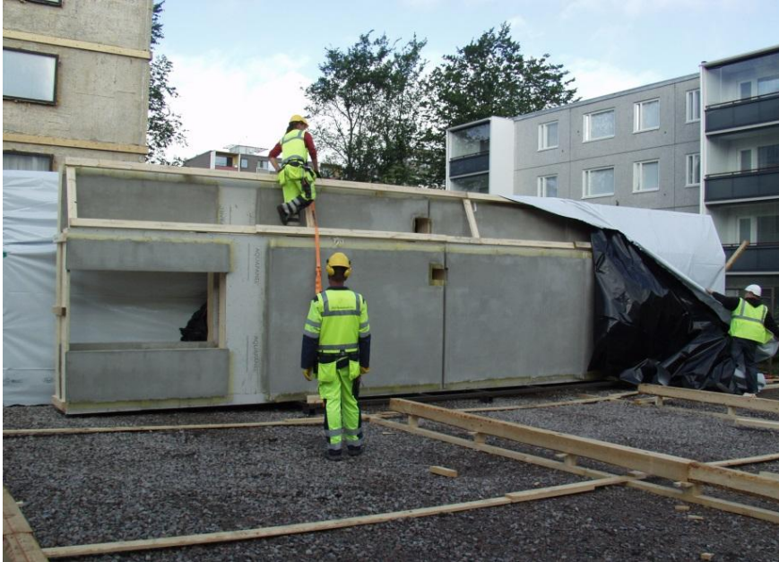
Kuva 16. Elementti purettu autosta.
