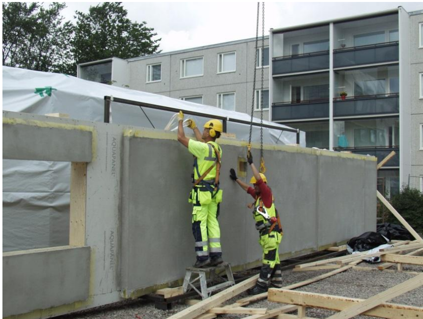
Kuva 17. Elementin valmistelua nostoa varten.
