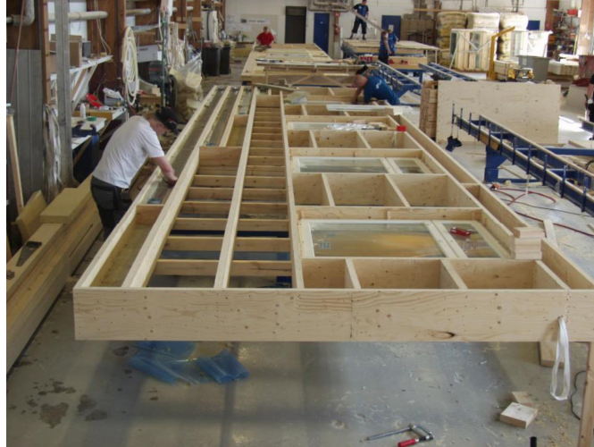
Kuva 10. TES-elementtien valmistusta tehtaalla.
