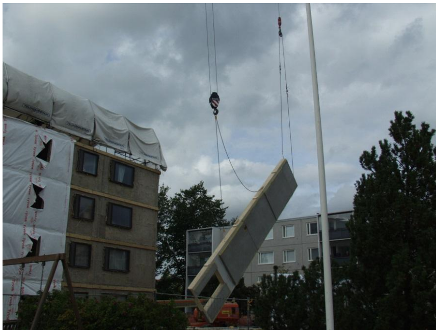
Kuva 19. Julkisivuelementin kääntö ilmassa.
