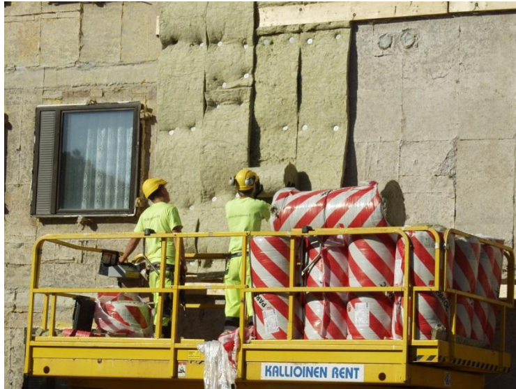
Kuva 7. Uusi kivillaeriste rullattiin vanhan sisäkuoren päälle.
