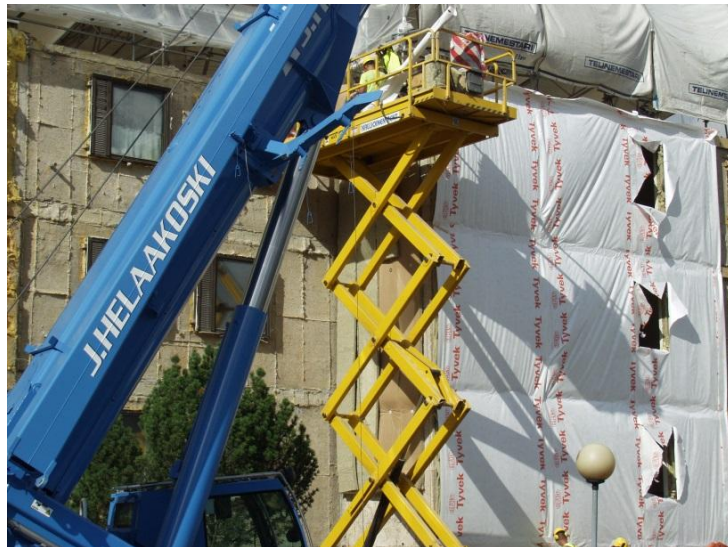
Kuva 8. Uuden kivillaeristeen asennusta.
