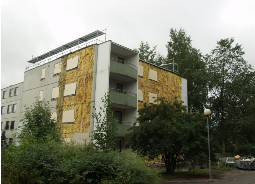
Kuva 4. Purettua julkisivua.
