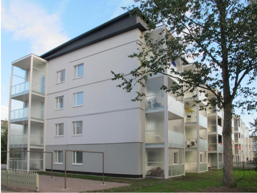
Kuva 25. Valmis kohde pihan puolelta (22.8.2012).
