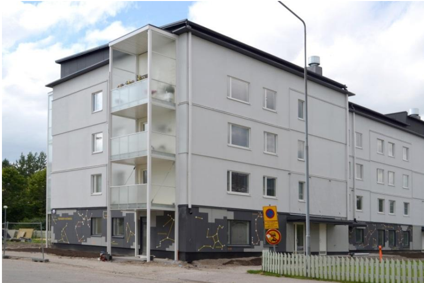
Kuva 23. Valmis kohde kadun puolelta (10.7.2012).
