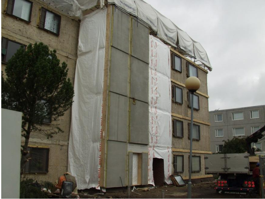
Kuva 20. Julkisivuelementtejä paikoillaan.
