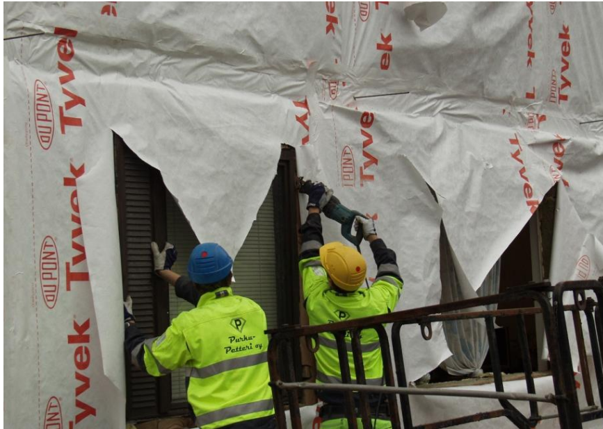
Kuva 6. Ikkunoiden poisto.
