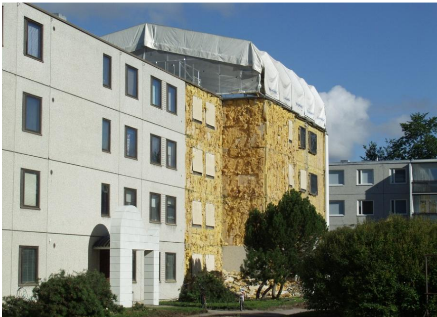
Kuva 5. Katon suojaus purkutöiden aikana.
