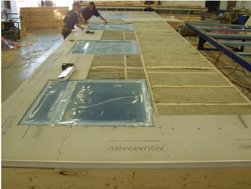
Kuva 13. TES-elementin ikkunoiden suojaus kuljetusta varten.
