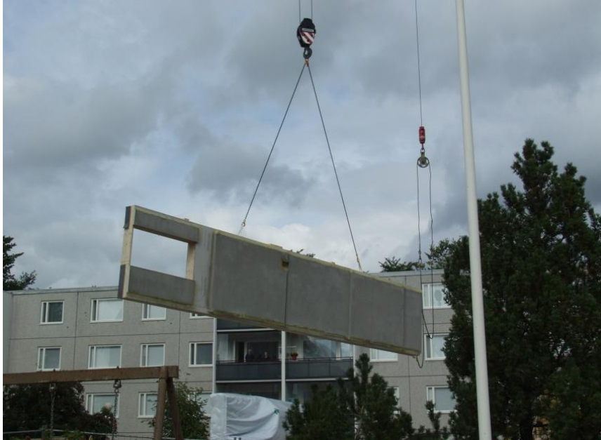
Kuva 18. Julkisivuelementin nosto.
