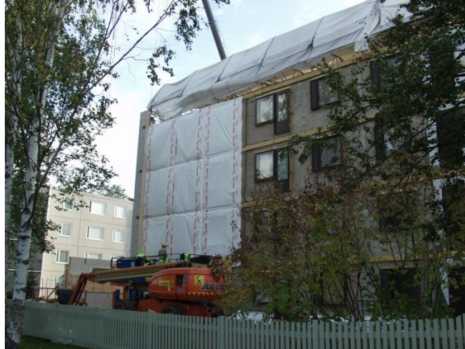
Kuva 9. Uuden eristekerroksen eri rakennusvaiheet samassa kuvassa.
