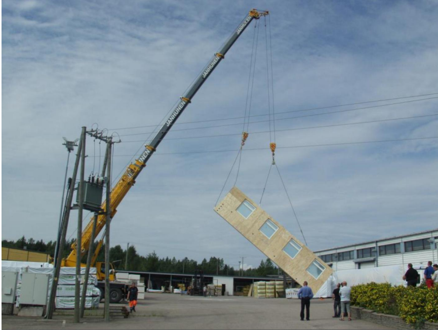
Kuva 15. TES-julkisivun koenosto tehtaan pihalla.
