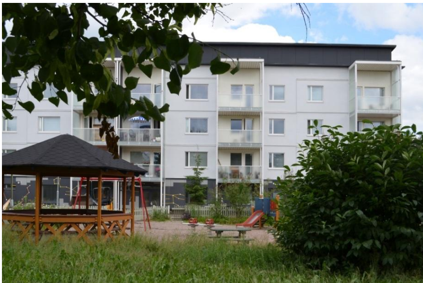
Kuva 24. Valmis kohde pihan puolelta (10.7.2012).
