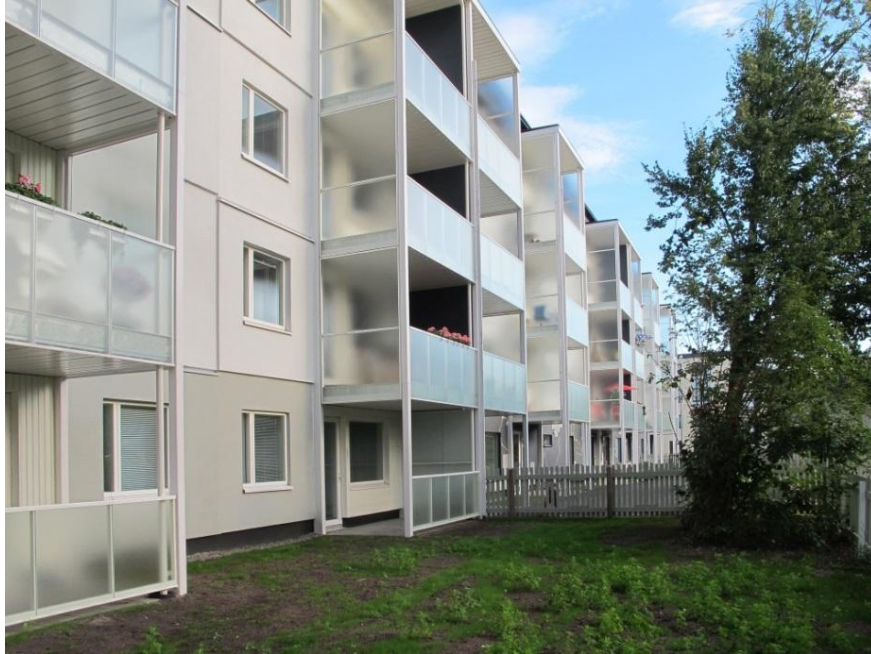
Kuva 26. Valmis kohde pihan puolelta (22.8.2012).
