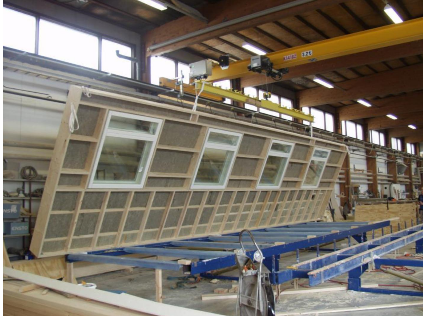
Kuva 12. Lähes valmis TES-elementti.
