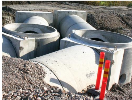
Kuva 11. Esimerkkejä läpäiseviä päällysteitä täydentävistä ratkaisuista ja tuotteista veden varastointiin tai viivytykseen: a) Hulevesikasettisysteemi (Rai-neo®/Pipelife Oy). b) Hulevesien imeyttäminen tunnelirakenteella (Kaitos Oy). c) ja d) Hulevesin siirrossa ja viivytyksessä käytettäviä betoniputkia ja -kaivoja.
