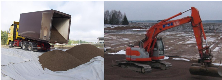
Kuva 13. Kuorman purku ja kevytsoran levitys (kuvat: Weber).
