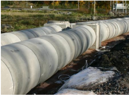
Kuva 11. Esimerkkejä läpäiseviä päällysteitä täydentävistä ratkaisuista ja tuotteista veden varastointiin tai viivytykseen: a) Hulevesikasettisysteemi (Rai-neo®/Pipelife Oy). b) Hulevesien imeyttäminen tunnelirakenteella (Kaitos Oy). c) ja d) Hulevesin siirrossa ja viivytyksessä käytettäviä betoniputkia ja -kaivoja.
