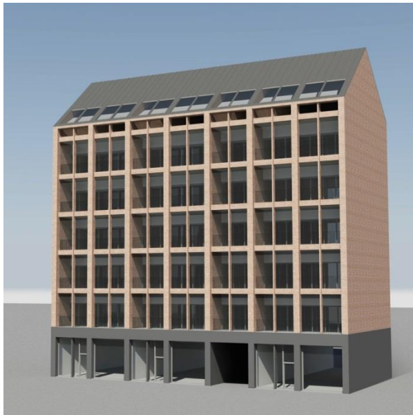
Kuva 10. SunZEB-kaupunkitalo. Perinteisen, helsinkiläisen umpikorttelikerrostalon malliin perustuvassa asuinkerrostalotyypissä on katujulkisivun mittainen lasitettu parvekevyyhyke, joka torjuu sisätilojen liiallisen yllämpenemisen.
