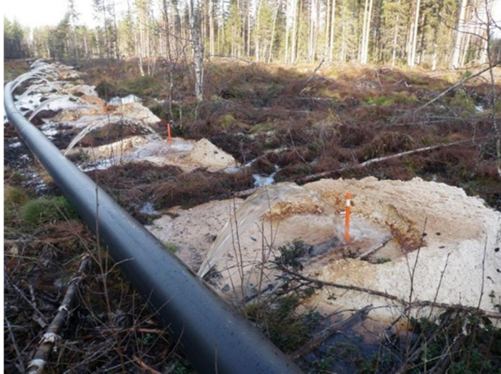
Kuva 35. Kalkkikasat sijoitettiin pintavalutuskentän paineputken vesisuihkujen kohdille.
