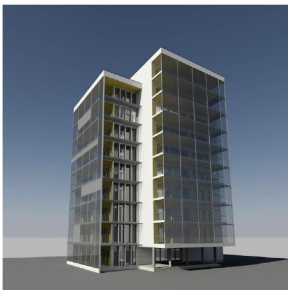
Kuva 13. Esimerkki SunZEB-pistetalosta. Lasitetut parvekkeet ja varjostava säileikkö ikkunoiden yläpuolella estävät sisätilojen liiallisen yllämpenemisen. (Shemeikka et al., 2015.)
