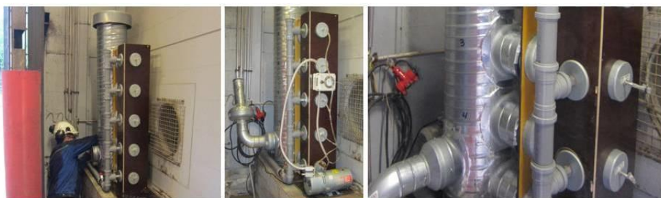
Kuva 30. Mittauslaitteiston asennus Naistenlahden voimalaitokselle.
