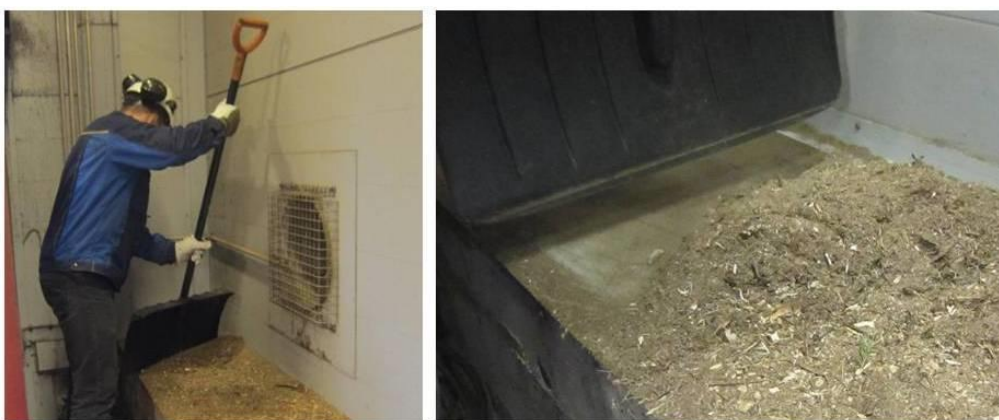
Kuva 29. Mittauslaitteiston asennus Naistenlahden voimalaitokselle.
