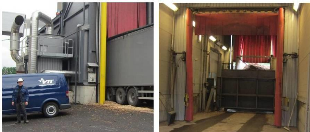
Kuva 26. Hakkeen purkupaikka Naistenlahden voimalaitoksella.
