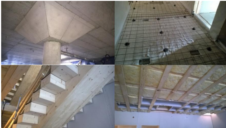
Kuva 28. Kivistön kohteen rakennusdetaljeja (autohallin betonipilari, välipohjan lattia ennen betonivalua, puinen porras ja asunnon kattoeristys ja koolaus).
