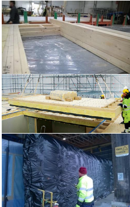
Kuva 27. Suurelementtien valmistus tehtaalla ja elementi pakattuna lähetettäväksi työmaalle.
