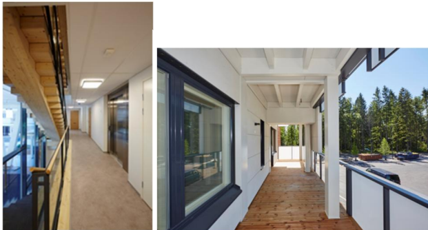
Kuva 29. Kivistön kohde rakennusvaiheessa sekä valmiina rakennuksena.
