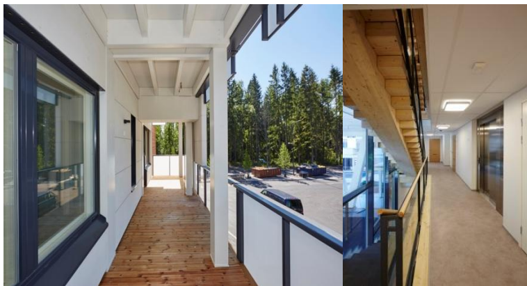
Kuva 25. Esimerkkikohde A:n kuvaus (Kivistön puukerrostalo Vantaalla).
