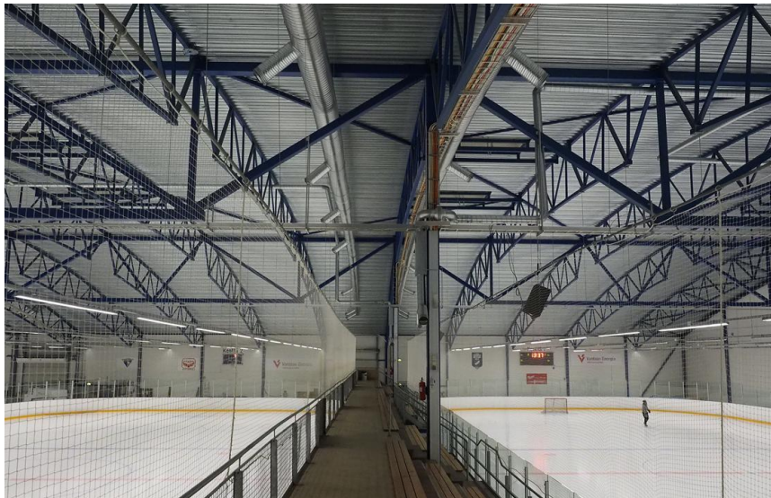
Kuva 14. Katon metallinen sisäpinta heijastaa lämpöä ja valoa (Malmin jäähalli).
