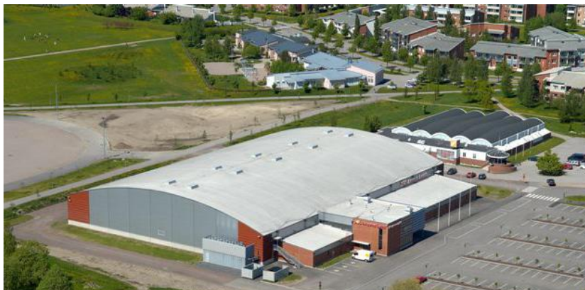
Kuva 13. Jäähallin vaalea vesikate (Sol Arena, Lahti, http://www.luh.fi/ ).
