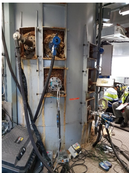
Kuva 2. Mittaustaso jätevoimalalla vertailumittauksissa toukokuu 2019.
