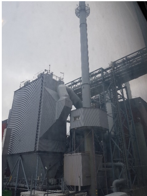
Kuva 2. Vertailumittausten piippu ja katettu mittauspaikka piipun ympärillä
