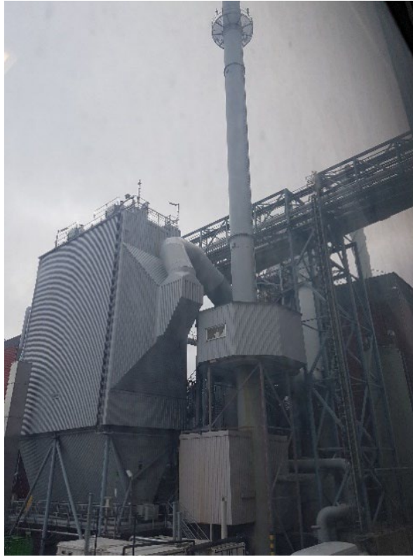
Kuva 2. Vertailumittausten piippu ja katettu mittauspaikka piipun ympärillä
